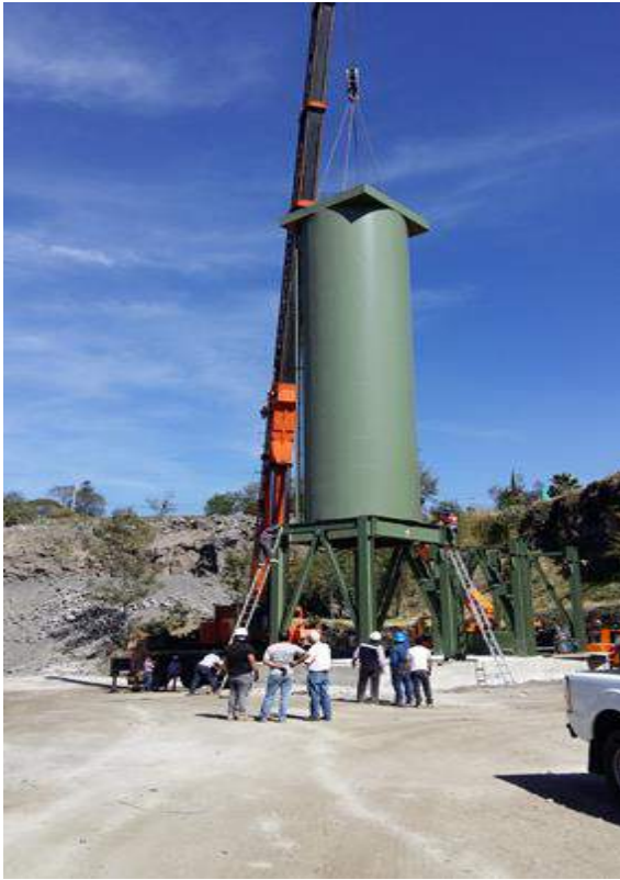
Montaje de silos con capacidad de almacenamiento de 200 toneladas
