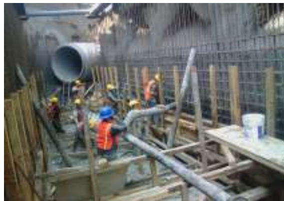
Colado de muros de galería
