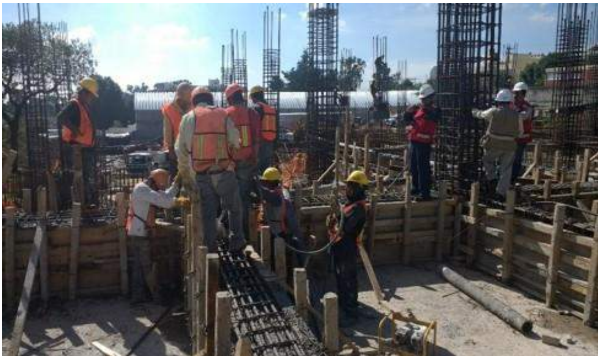
Cimbra de columnas y contratrabes
