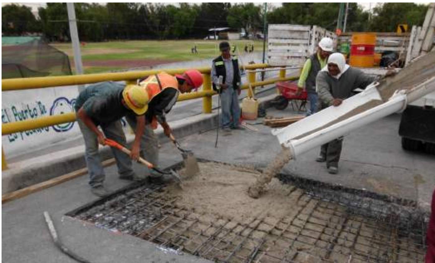
Colocación de concreto hidráulico
