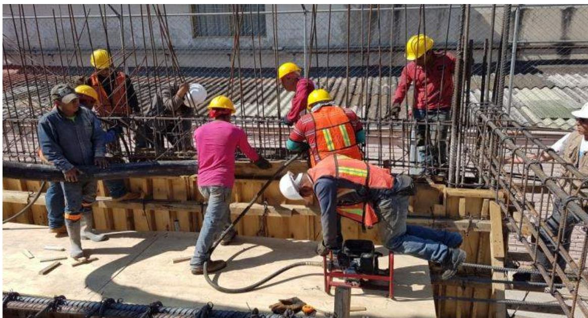
Colado de traveses perimetrales
