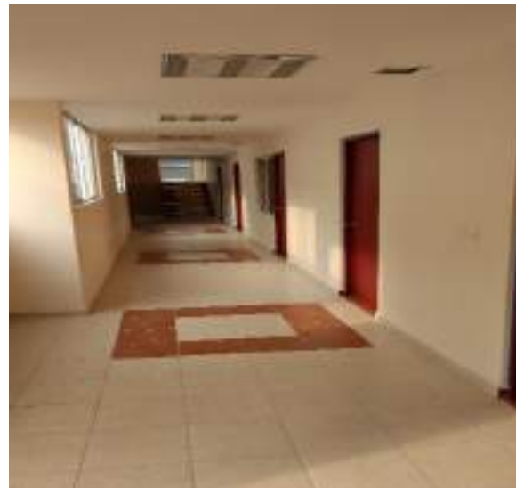
Colocación de pisos cerámicos
