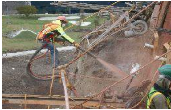
Colocación de concreto lanzado
