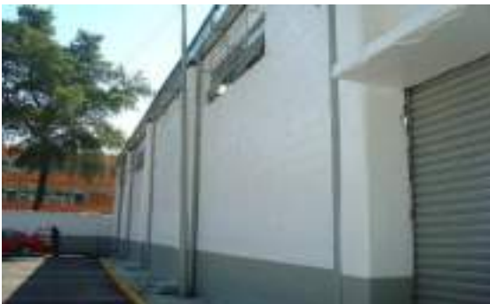
Pintura en muros y habilitado de cortinas
