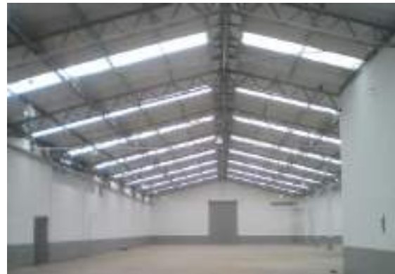
Colocación de lámina Glamet
