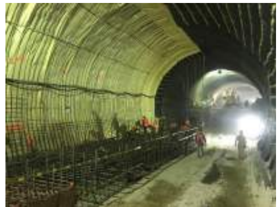
Armado de muro de contención
