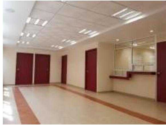
Colocación de puertas
