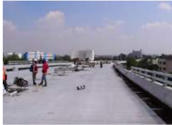
Colado de firme de compresión
