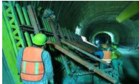
Reforzamiento de talud
