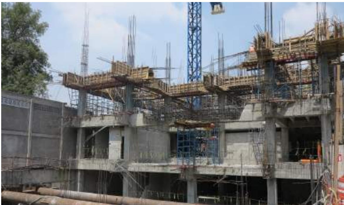
Cimbra para colado de estructuras
