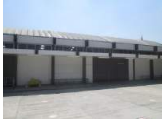
Colocación de cancelería de aluminio
