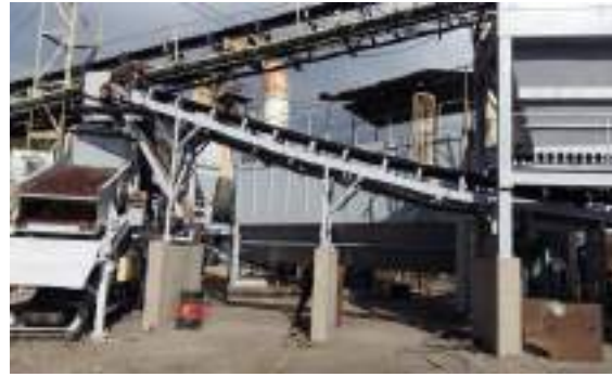
Tolvas, banda transportadora y criba con anticorrosivo
