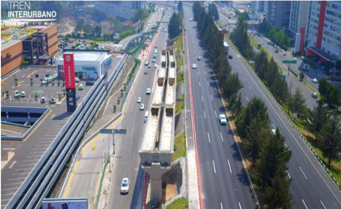
Frente Centro Comercial Santa Fe
