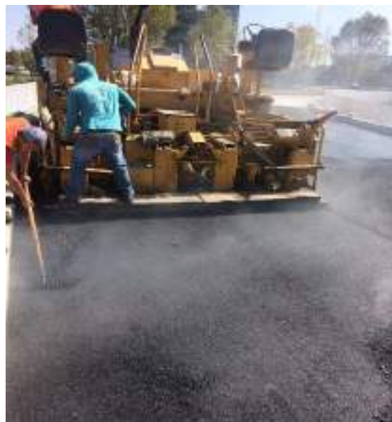
Compactación de carpeta
