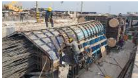
Ajuste de molde para colado
