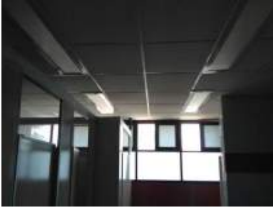
Instalación de red de voz y datos
