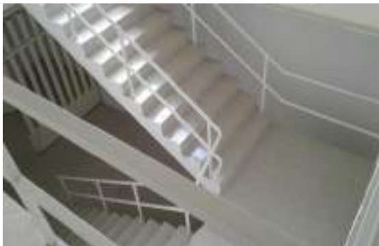
Instalación de barandales en escaleras
