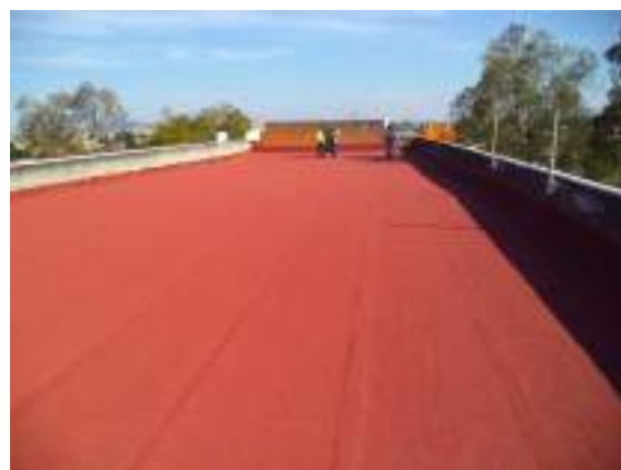
Colocación de impermeabilizante en azoteas
