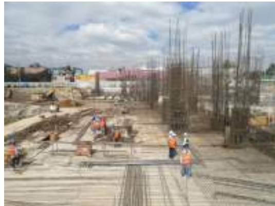
Habilitación de acero
