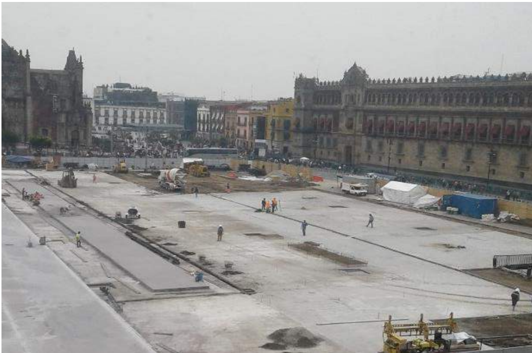
Compactación y nivelación del terreno
