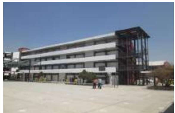
Acabados en fachadas
