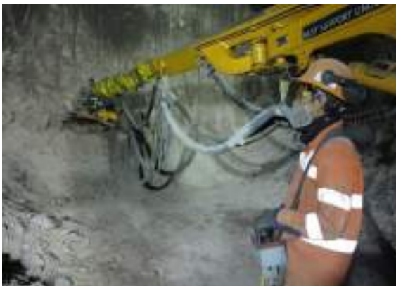
Perfilado en excavación
