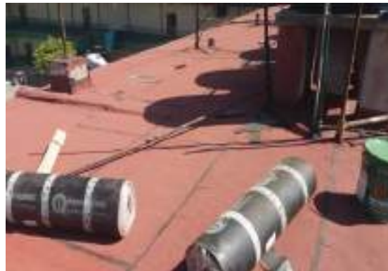
Suministro y colocación de impermeabilizante
