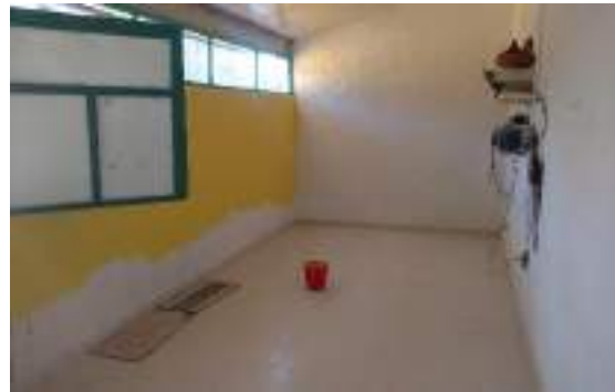
Mantenimiento y pintura
