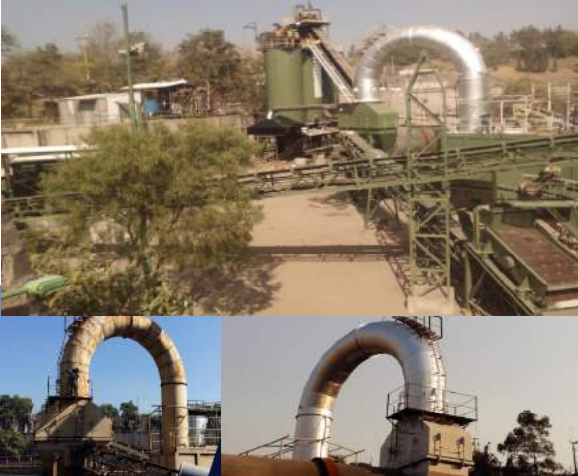
Mantenimiento al ducto de casa de bolsas
