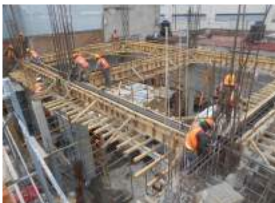
Habilitación de acero y madera para colado de elementos estructurales
