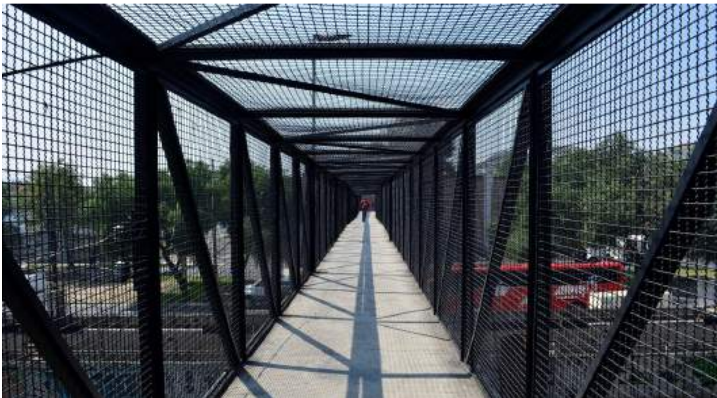
Trabajos de rehabilitación en estructura metálica
