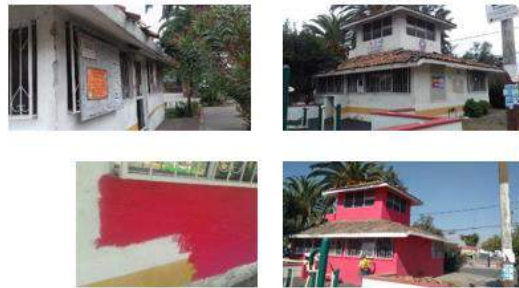
Trabajos de albañilería y aplicación de pintura en fachada
