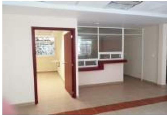
Colocación de pisos
