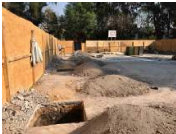
Construcción de registro para drenaje
