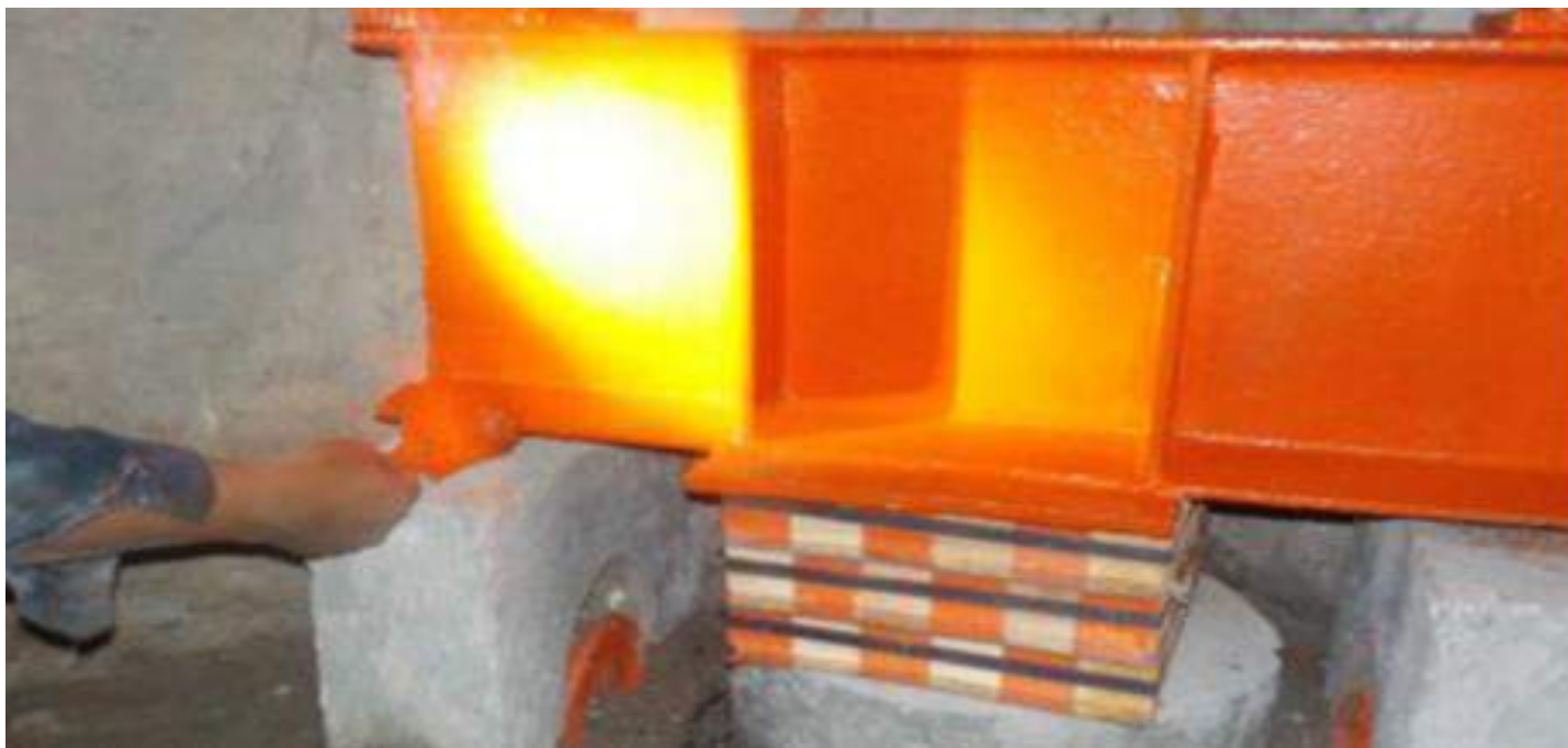
"Aplicación de pintura en partes metálicas"
