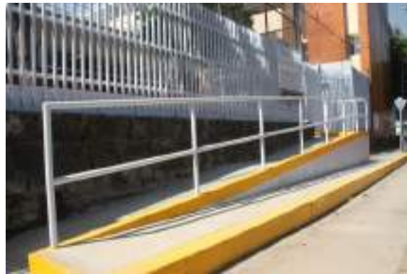
Construcción de rampas
