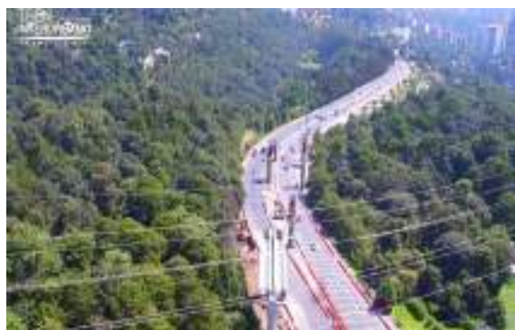
Segundo cruce- Autopista
