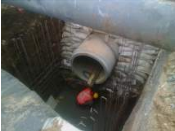
Excavación de caja de conexión
