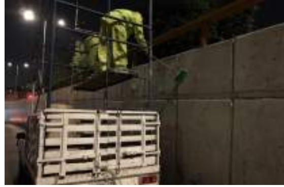
Lavado en muro de contención
