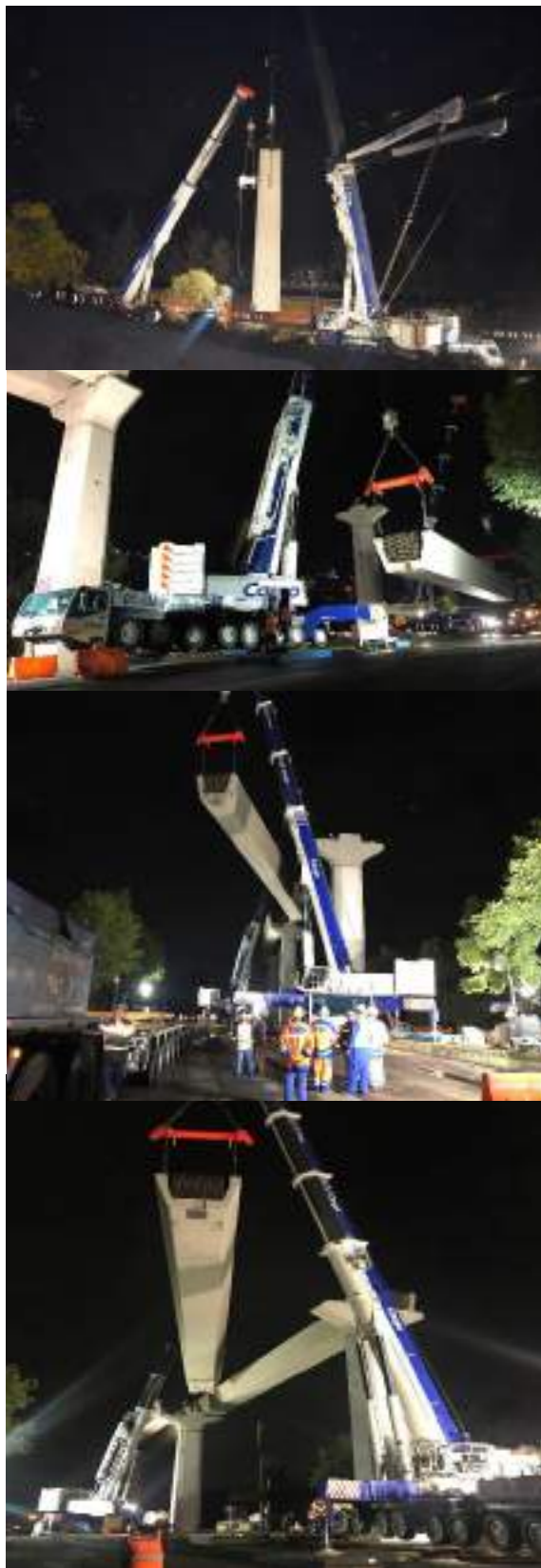
Montaje de elementos prefabricados
