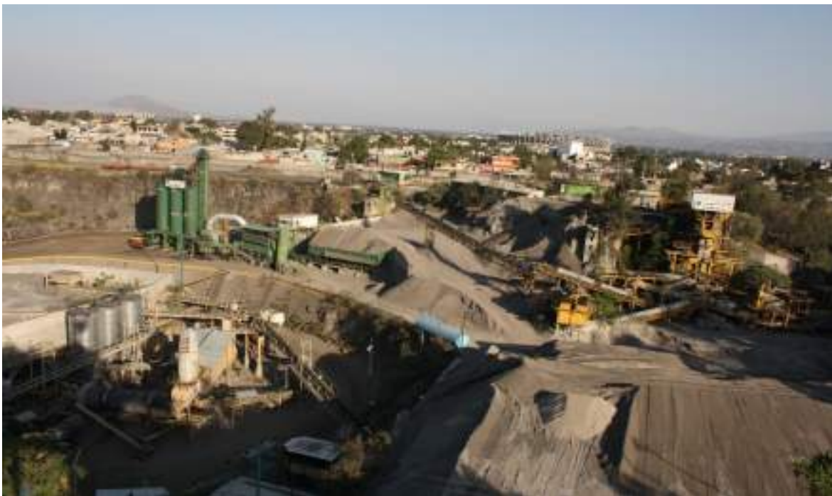
Vista panorámica de la Planta de Asfalto
