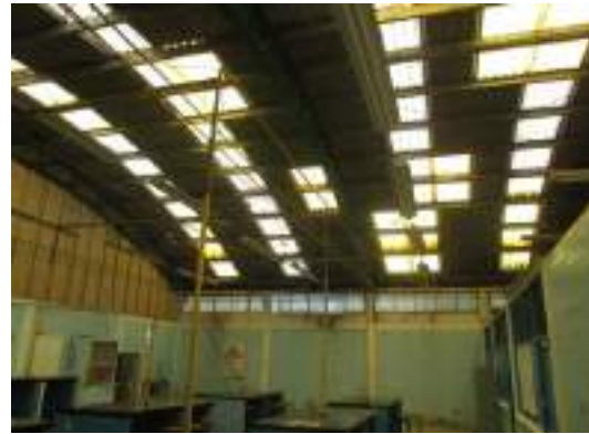
Cubiertas ligeras que permiten el paso de luz natural
