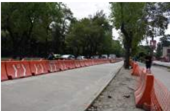
Confinamiento en zona de obra
