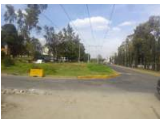
Instalaciones aéreas a reubicar
