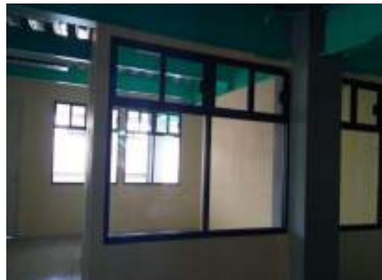
Suministro y colocación de cancelería
