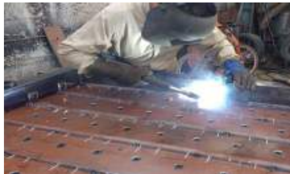
Aplicación de soldadura
