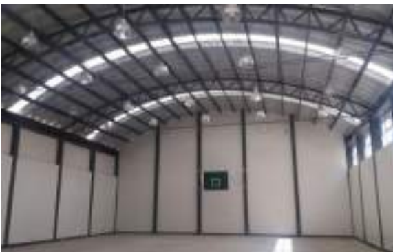
Suministro y colocación de cubiertas ligeras
