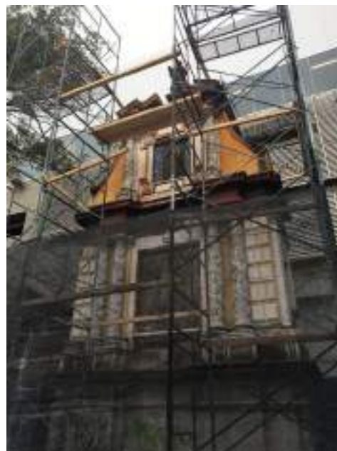
Restauración de Estela
