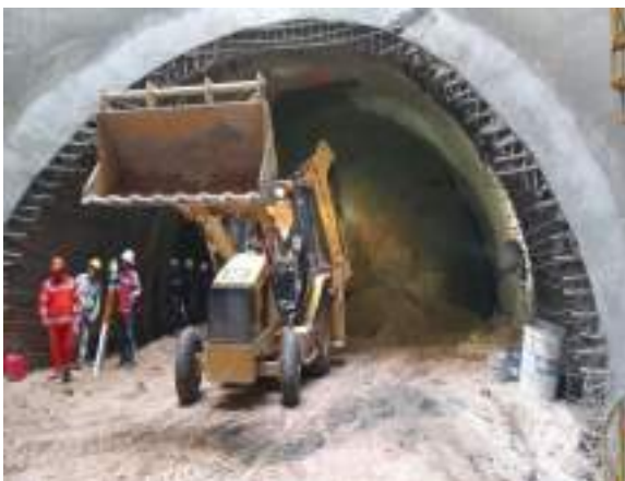
Retiro de material
