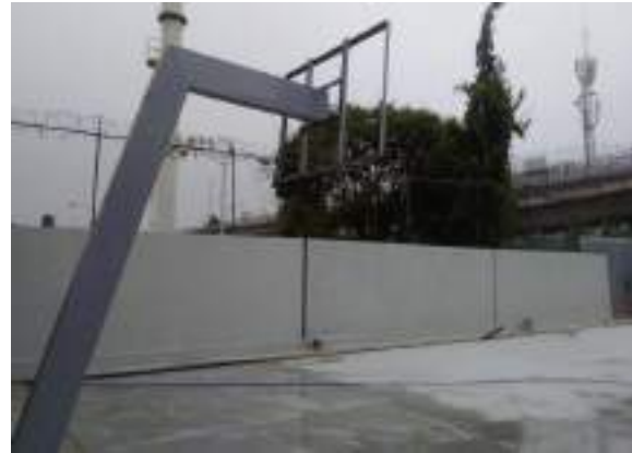
Construcción de cancha de basquetbol
