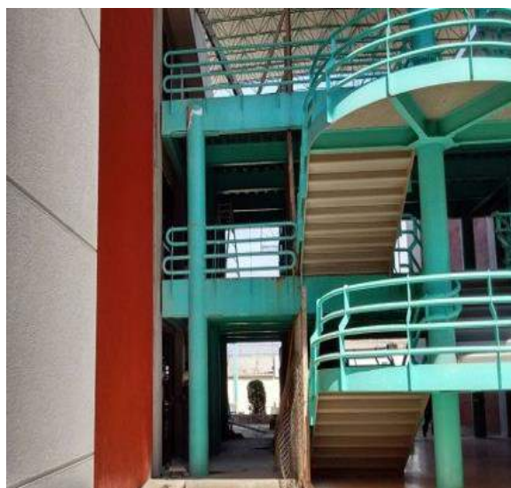
Vista del núcleo de escaleras
