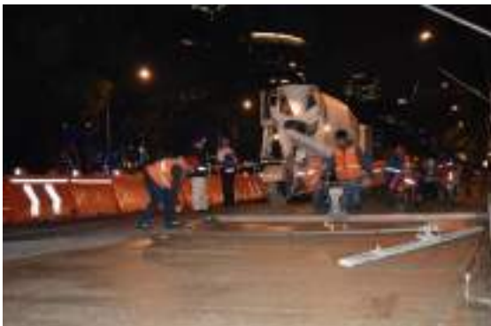
Enrazado de concreto hidráulico
