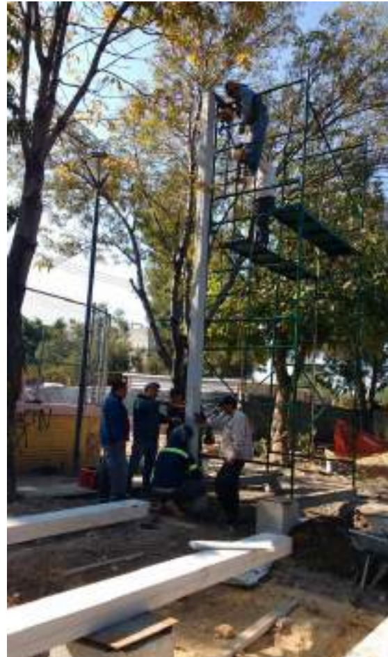
Colocación de estructura vertical
