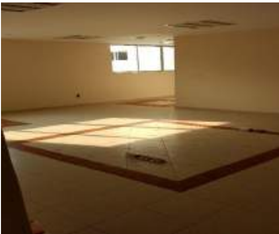
Aplicación de pintura en muros interiores
