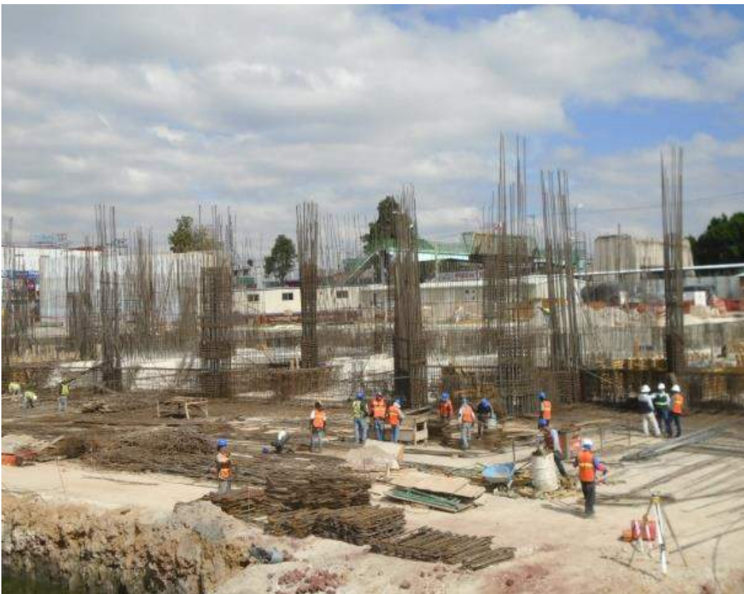
Armado para colado de elementos estructurales
