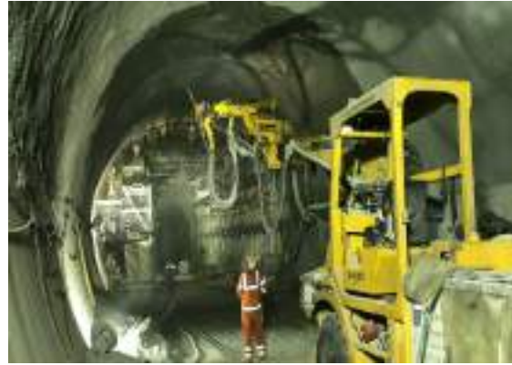
Lanzado de concreto
