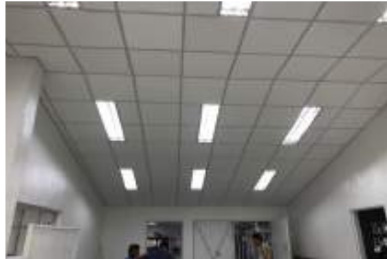
Reparación de instalación eléctrica
