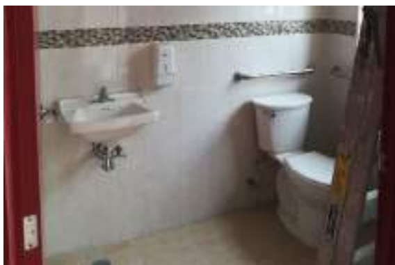
Acabado en instalación sanitaria
