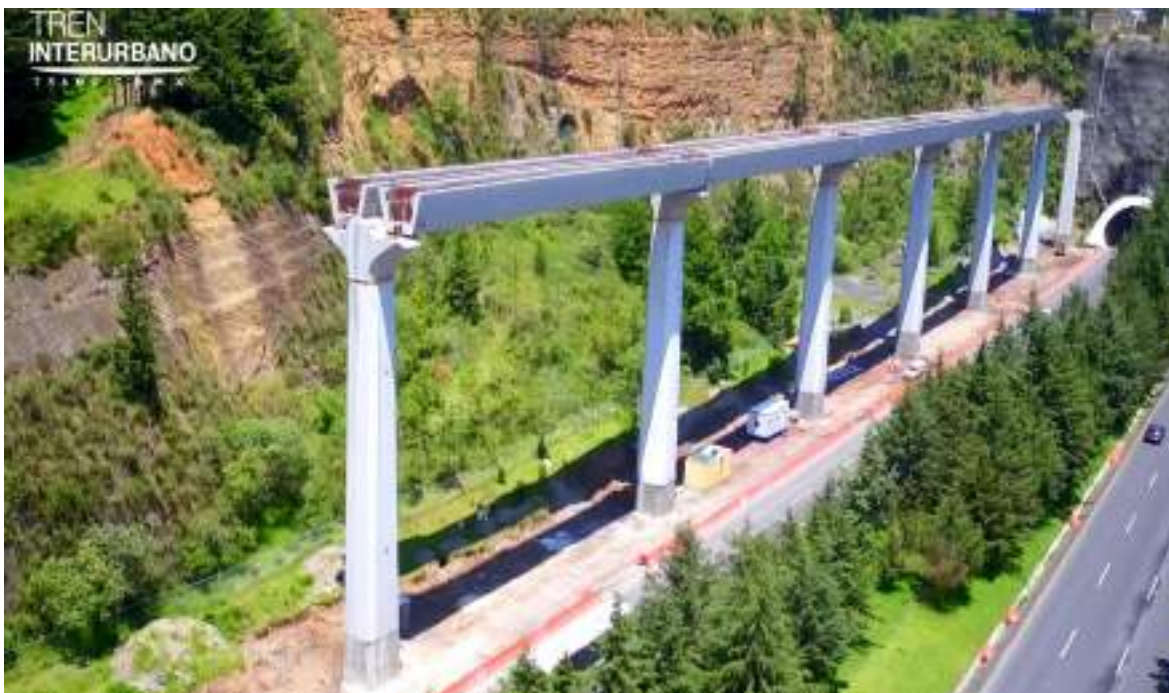
Montaje de elementos estructurales verticales y horizontales
