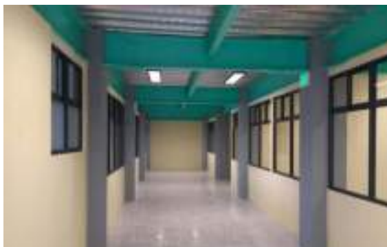
Mantenimiento de instalaciones eléctricas
