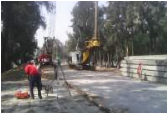
Entongado de pilotes para cimentación
