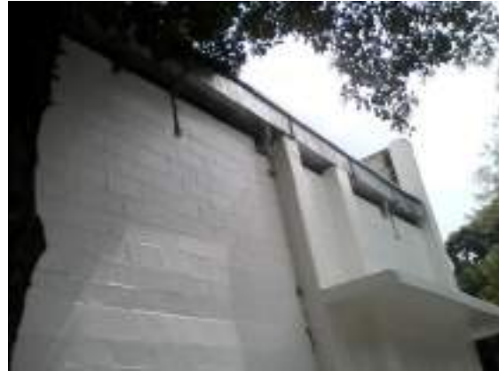
Aplicación de pintura en muros exteriores
