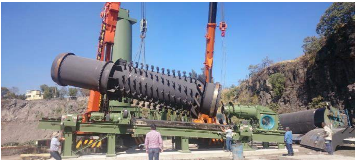
Colocación del chasis con quemador
