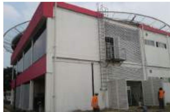
Vista cuarto de máquinas
