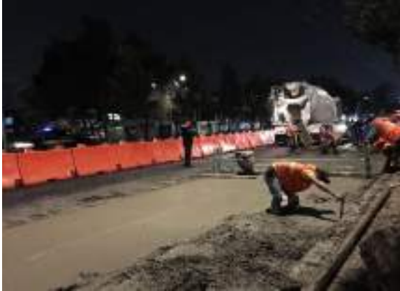
Suministro y colocación de concreto
