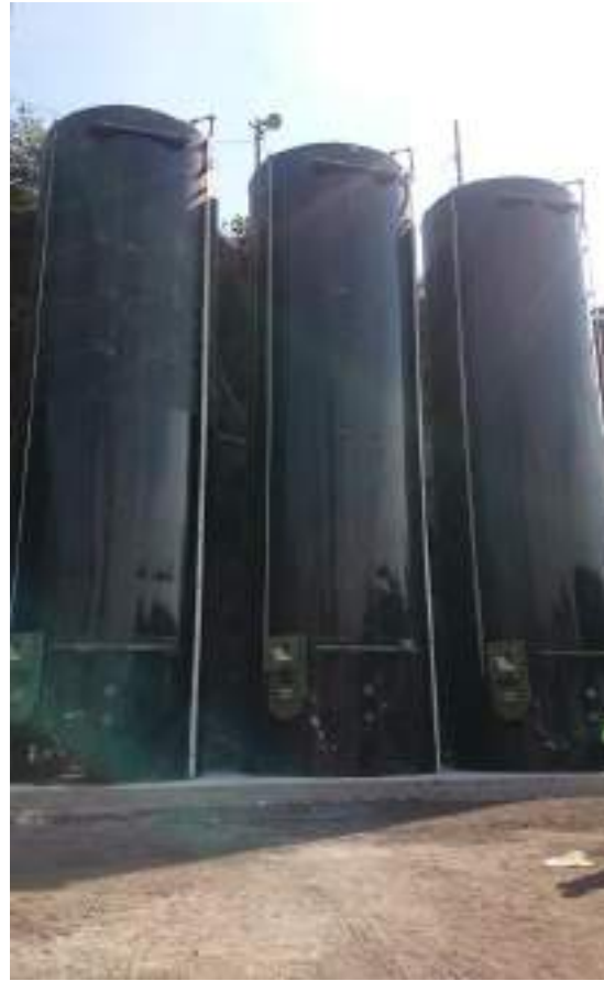
Nuevos tanques para almacenamiento de AC-20 Planta No. 9
