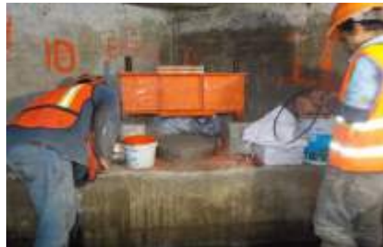
Reparación del banco que resguarda la rótula
