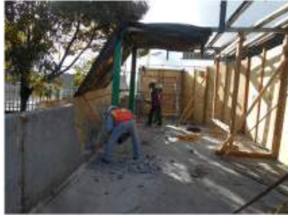
Colocación de tapiales
