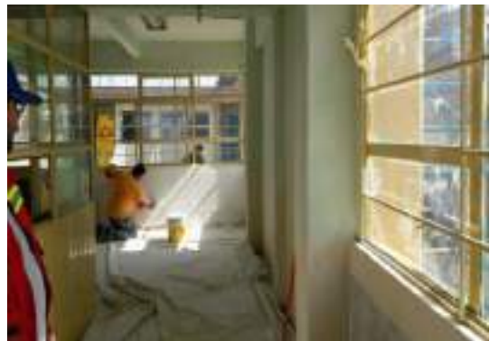
Suministro y aplicación de pintura en interiores
