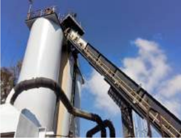
Aplicación de anticorrosivo a los silos de producto terminado
