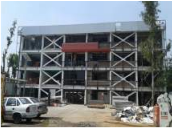
Estructura metálica para la edificación B y C
