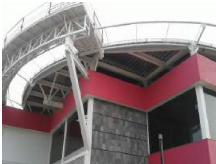
Vista del helipuerto
