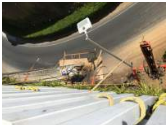
Colocación de andamios
