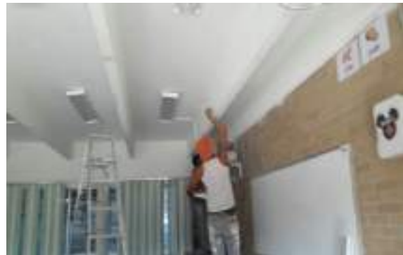
Suministro y colocación de luminarias
