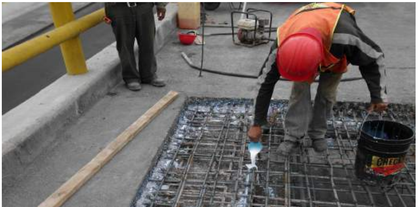
Preparación del acero previo al colado
