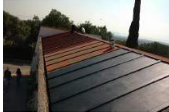
Impermeabilización de cubiertas
