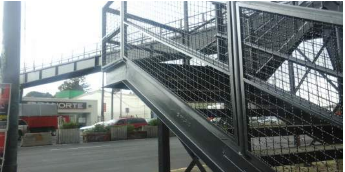
Rehabilitación de barandales
