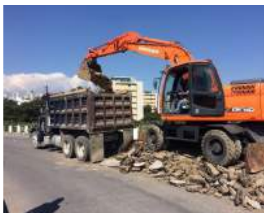
Levantamiento de escombros
