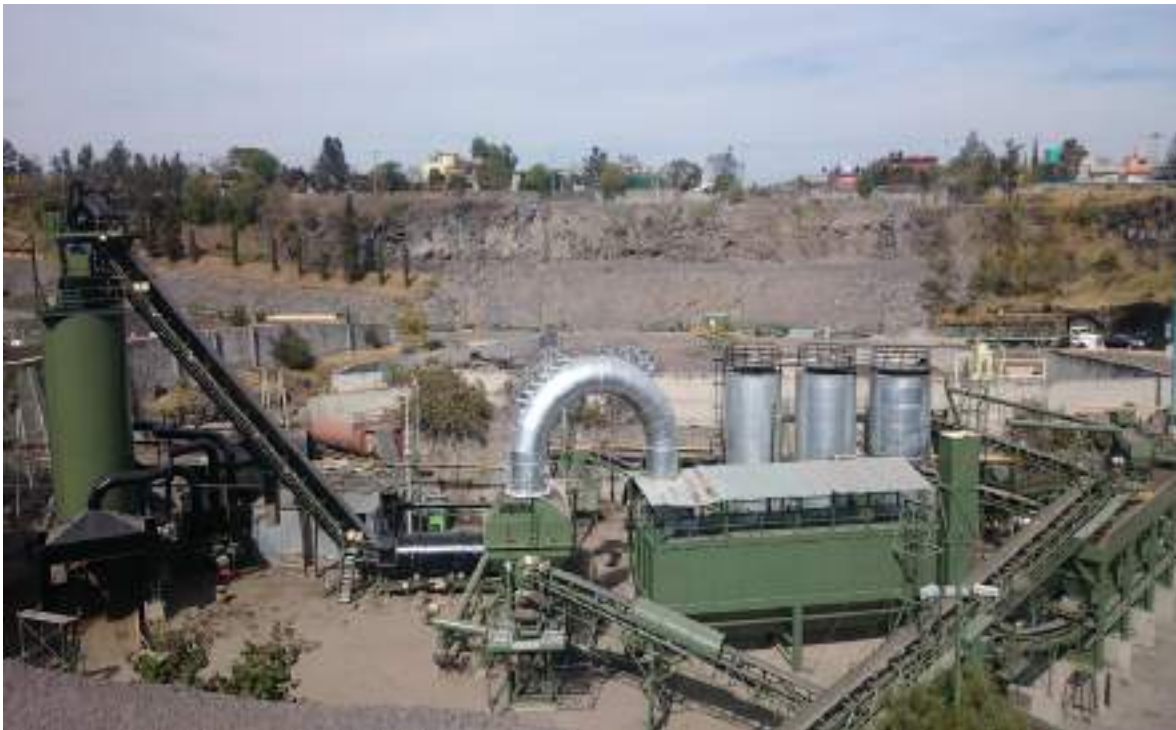
Colocación del nuevo ducto de extracción (Actual)
