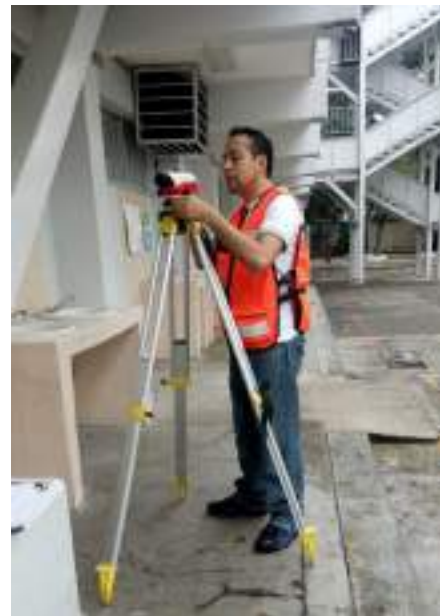
Verificación topográfica del inmueble
