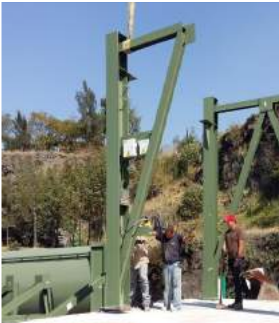
Montaje de las bases para los silos Planta No. 9
