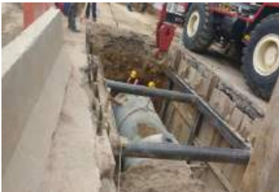
Colocación de cama de arena para recibir tubería
