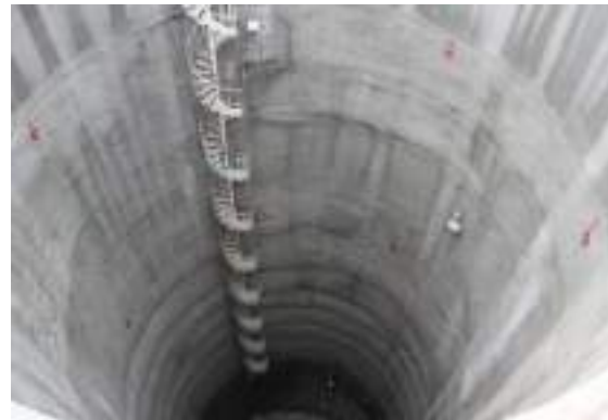
Vista de acceso a lumbrera
