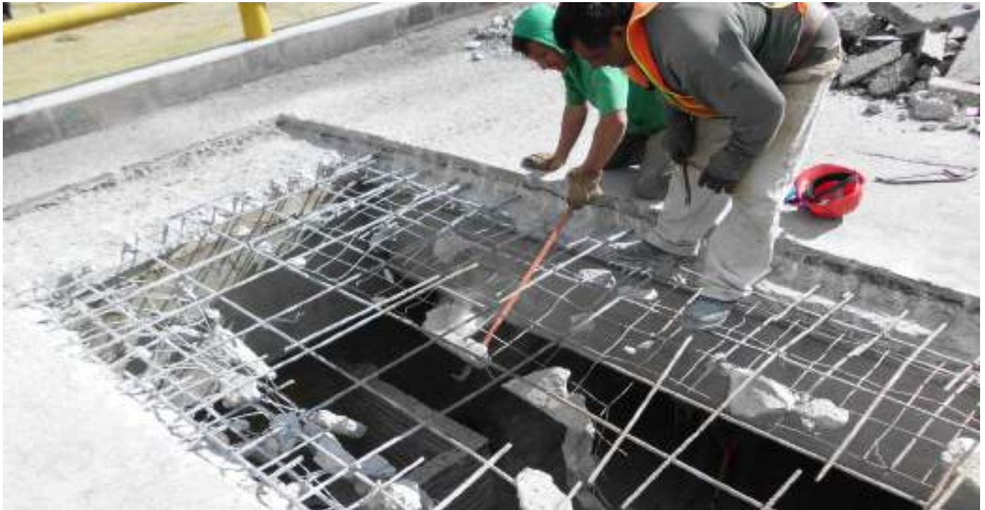
Demolición de losa de concreto
