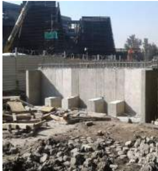
Construcción de Puente Peatonal, Ciclista y Vehicular
