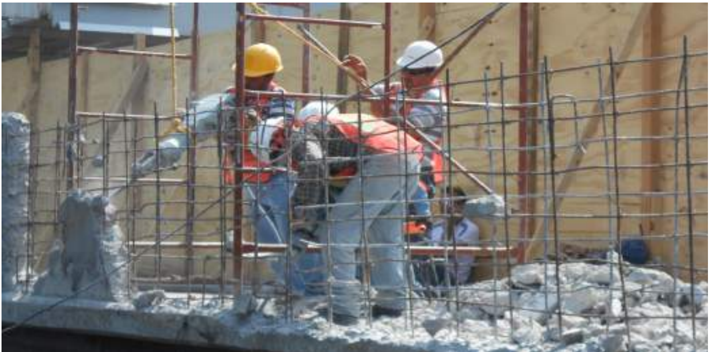
Demolición y reposición de elementos de concreto
