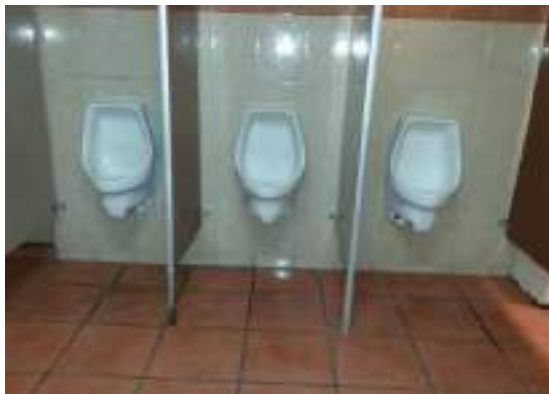
Suministro y colocación de mingitorios
