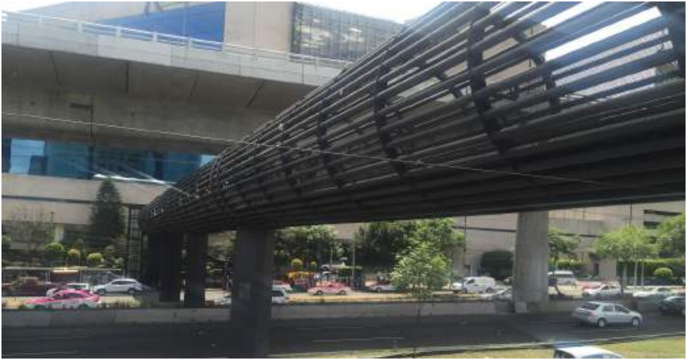
Pintura en estructura metálica
