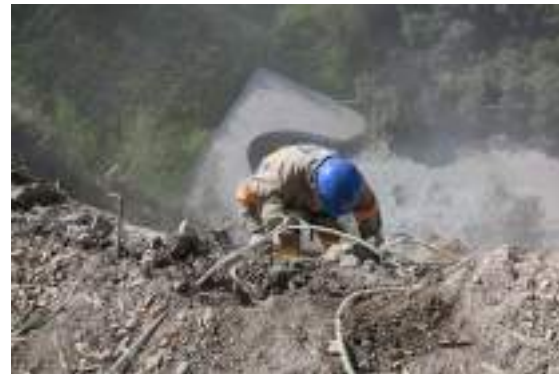
Descenso para trabajos de perfilado de talud
