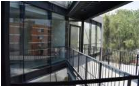
Instalación de Barandales
