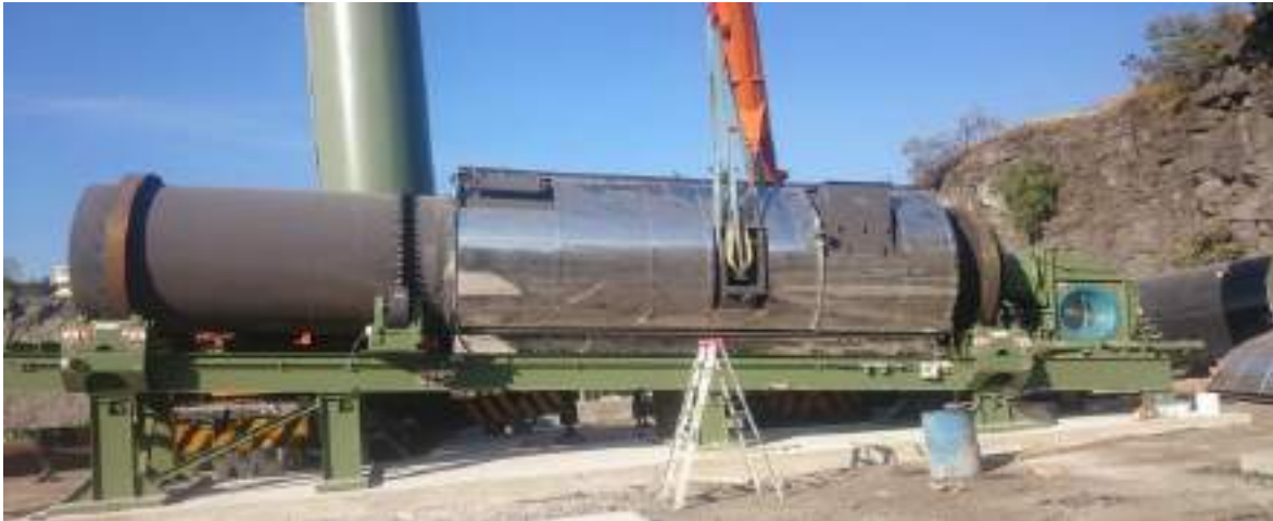
Montaje de la cubierta del doble barril
