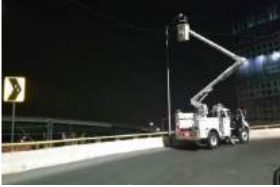
Mantenimiento de alumbrado público
