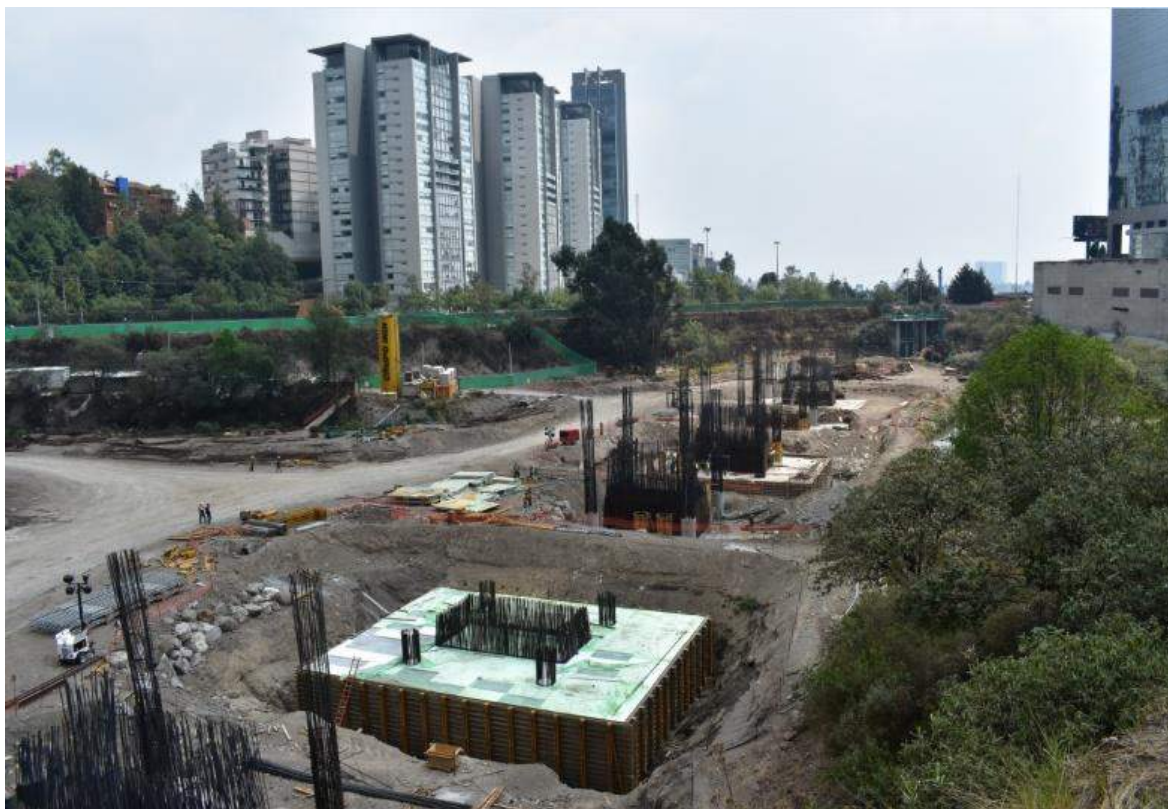
Zapatas para cimentación en Santa Fe
