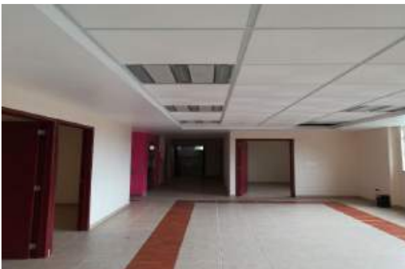
Aplicación de pintura en muros interiores
