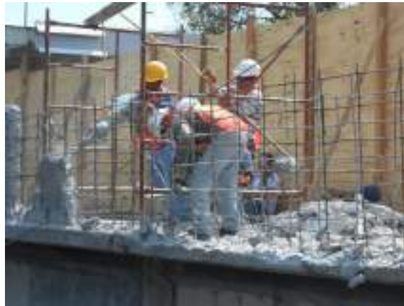
Retiro de murete
