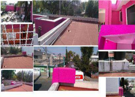
Diversos trabajos de mantenimiento
