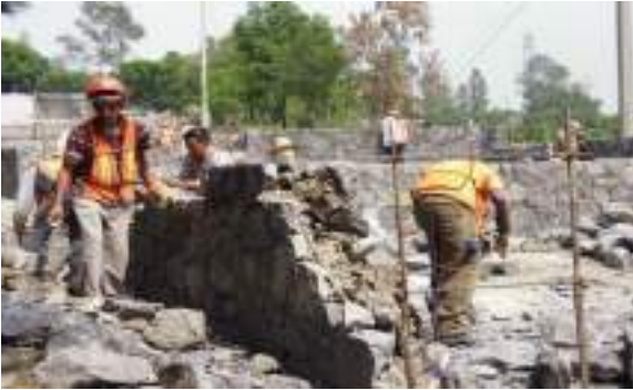
Uso de material pétreo existente
