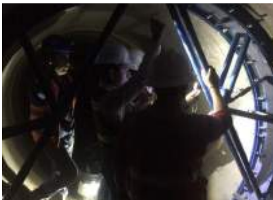
Estructura de refuerzo
