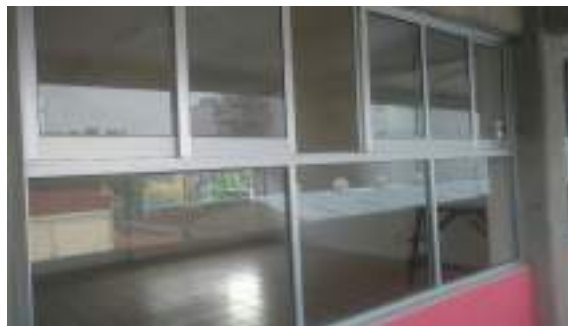
Suministro y colocación de cancelería de aluminio
