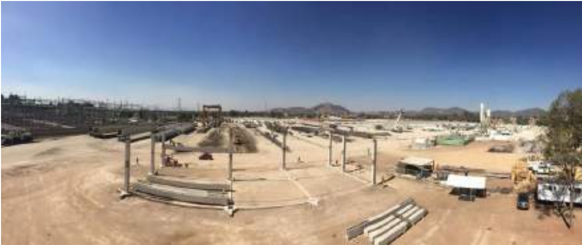
Patios de planta de prefabricados (Columnas, trabes, capiteles y pre-losas)
