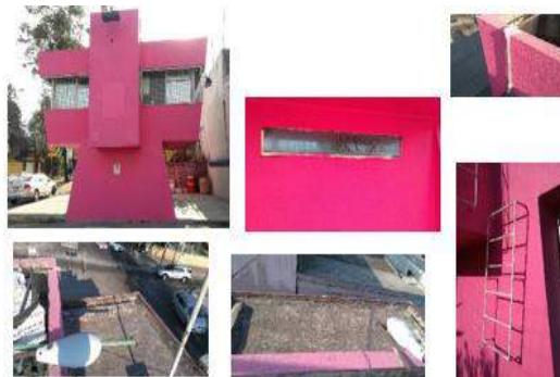
Trabajos de impermeabilización
