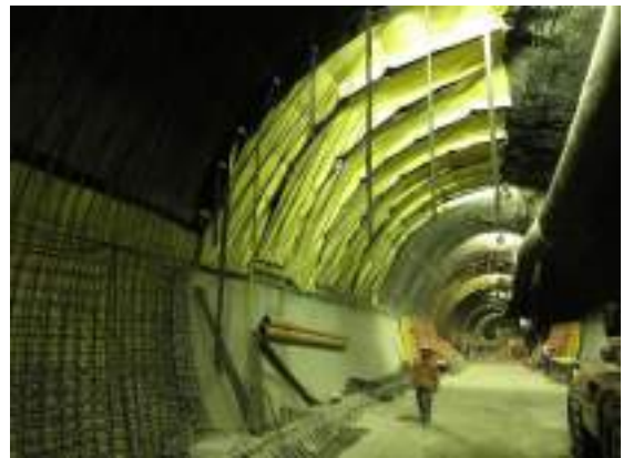
Colado en muros
