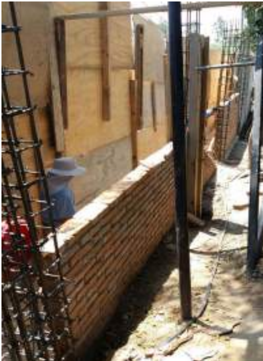
Construcción de muro de tabique
