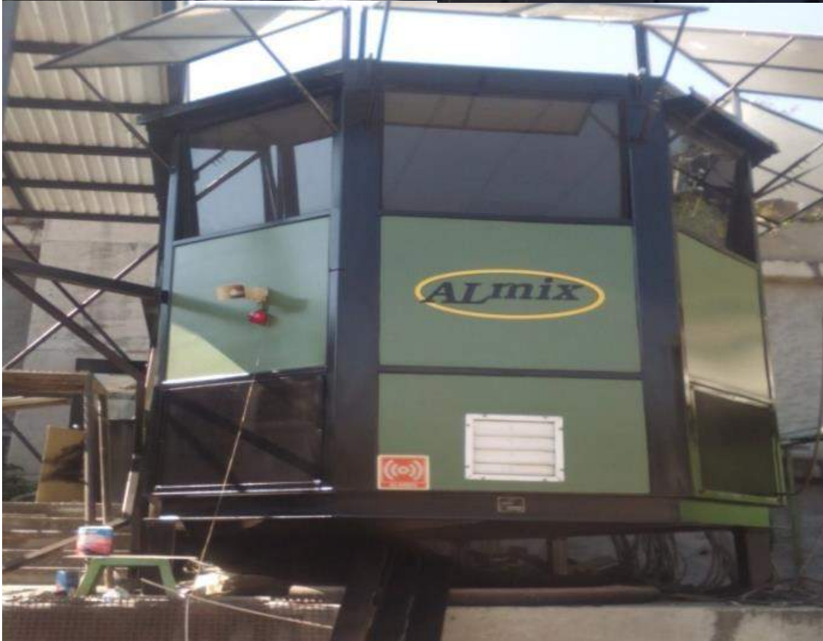
Caseta de control en la actualidad
