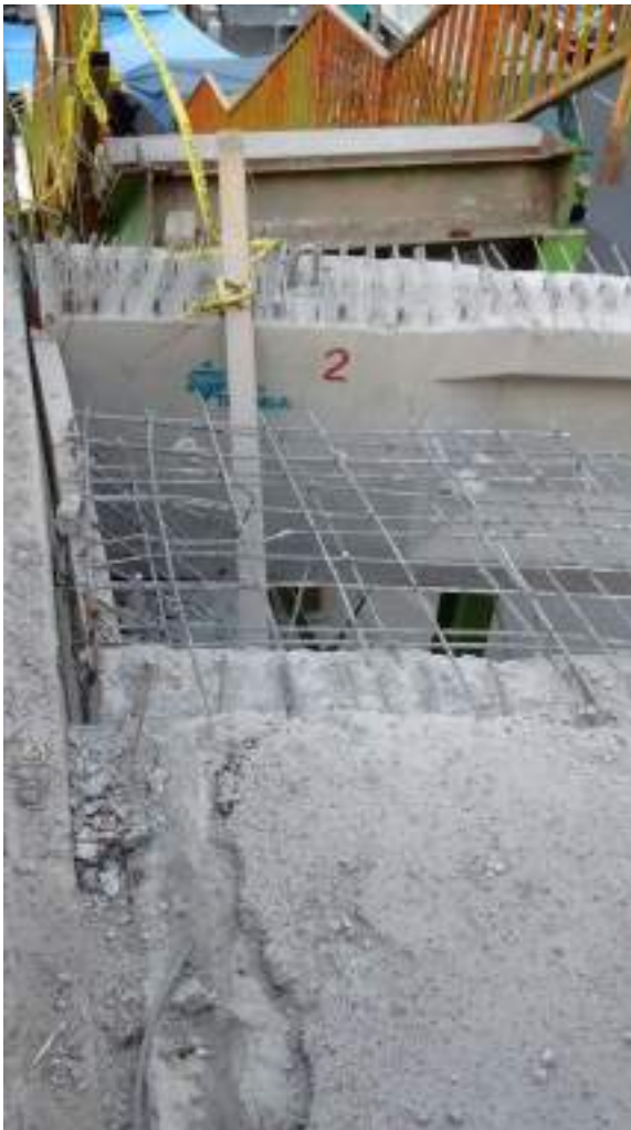
Reposición de concreto de pasarela
