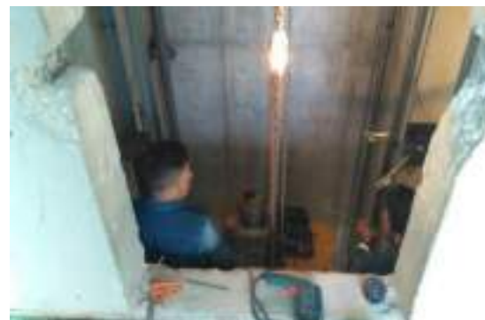
Suministro e instalación de elevador
