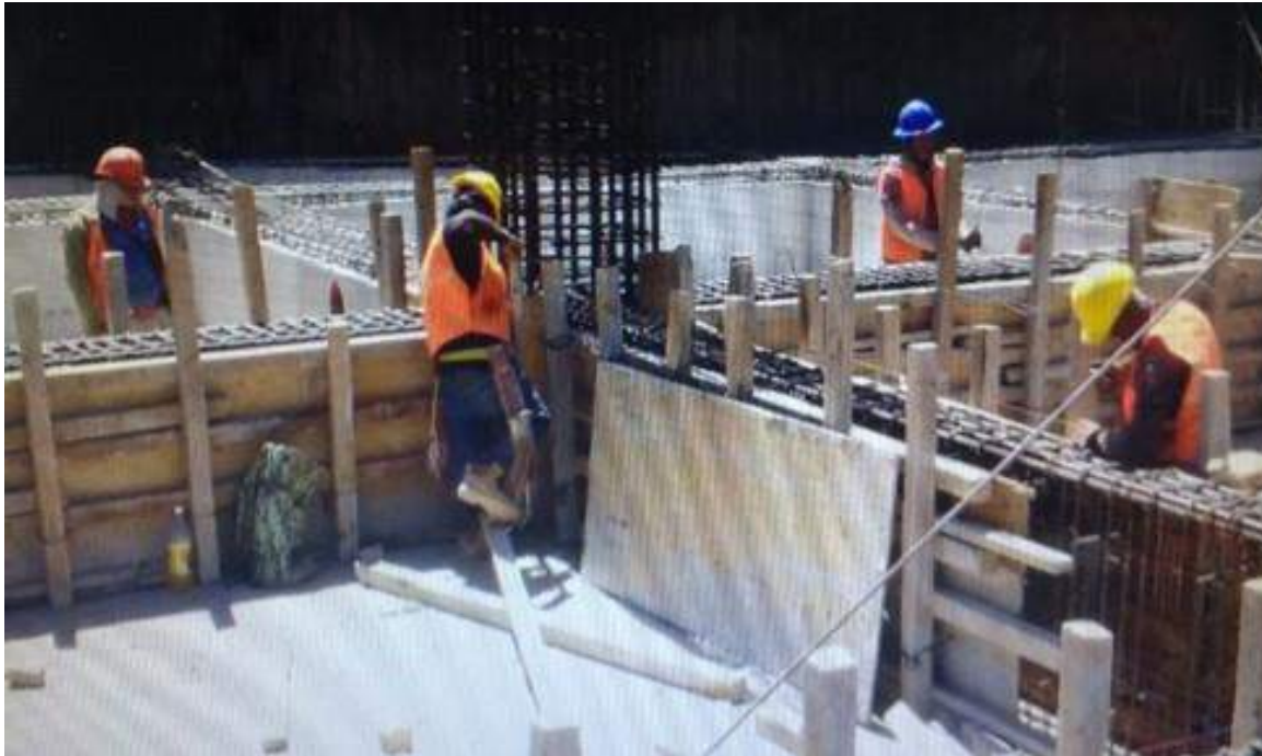
Cimbrado de contratraves en cimentación
