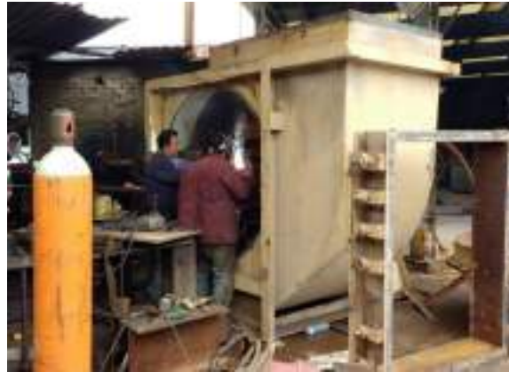
Reparación de ventilador
