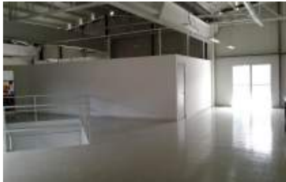
Colocación de puertas
