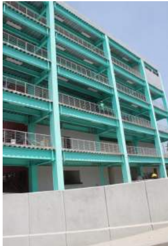
Suministro y aplicación de pintura en fachadas
