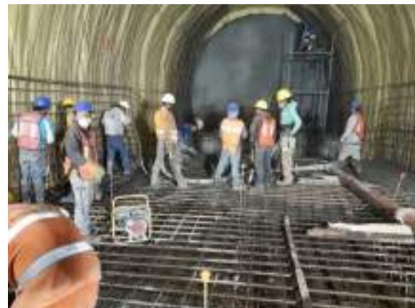
Armado de losa de fondo
