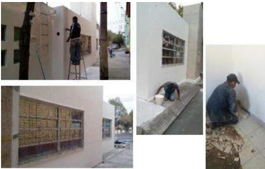
Trabajos de albañilería en muros y cambio de loseta en pisos
