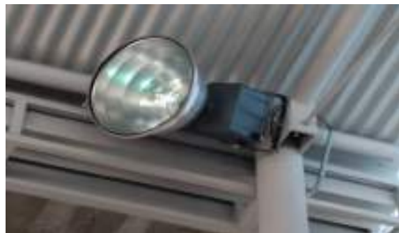
Colocación de reflectores
