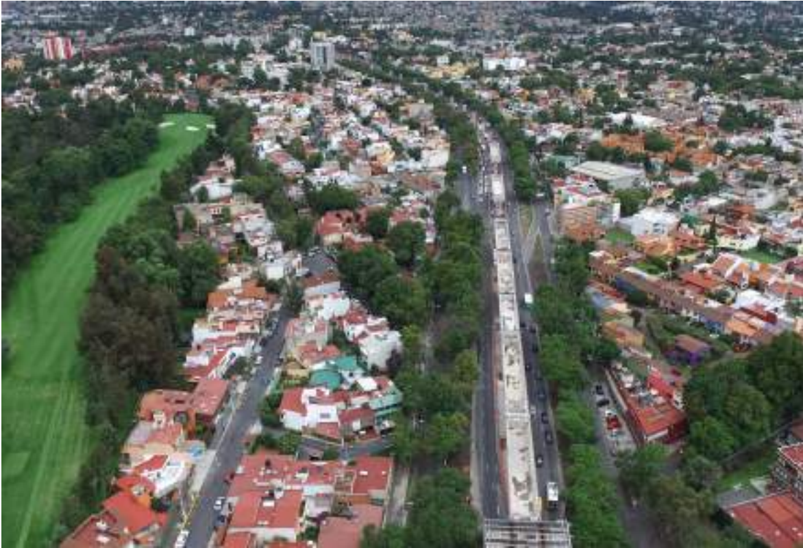
Vista panorámica del tramo construido
