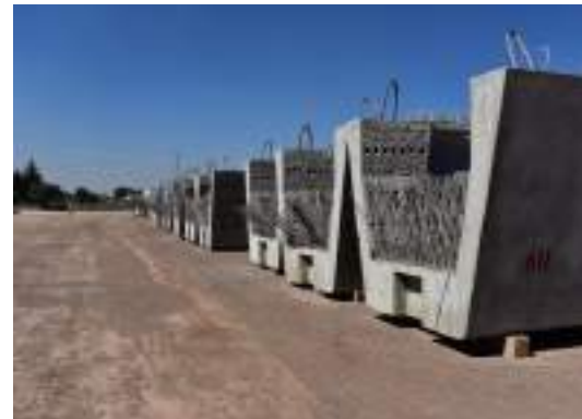
Elementos prefabricados (Trabes)
