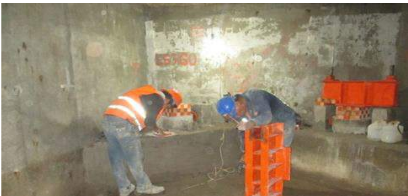
"Reparación de pilote de control"
