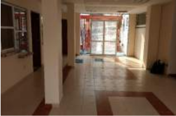
Colocación de puertas de cristal
