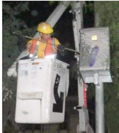
Limpieza de señalamiento
