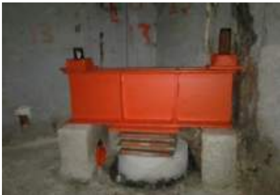
Reposición de cubos de madera y nivelación del puente de control
