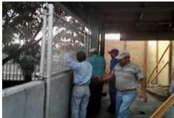
Colocación de malla
