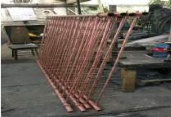
Construcción de elementos internos de conductividad
