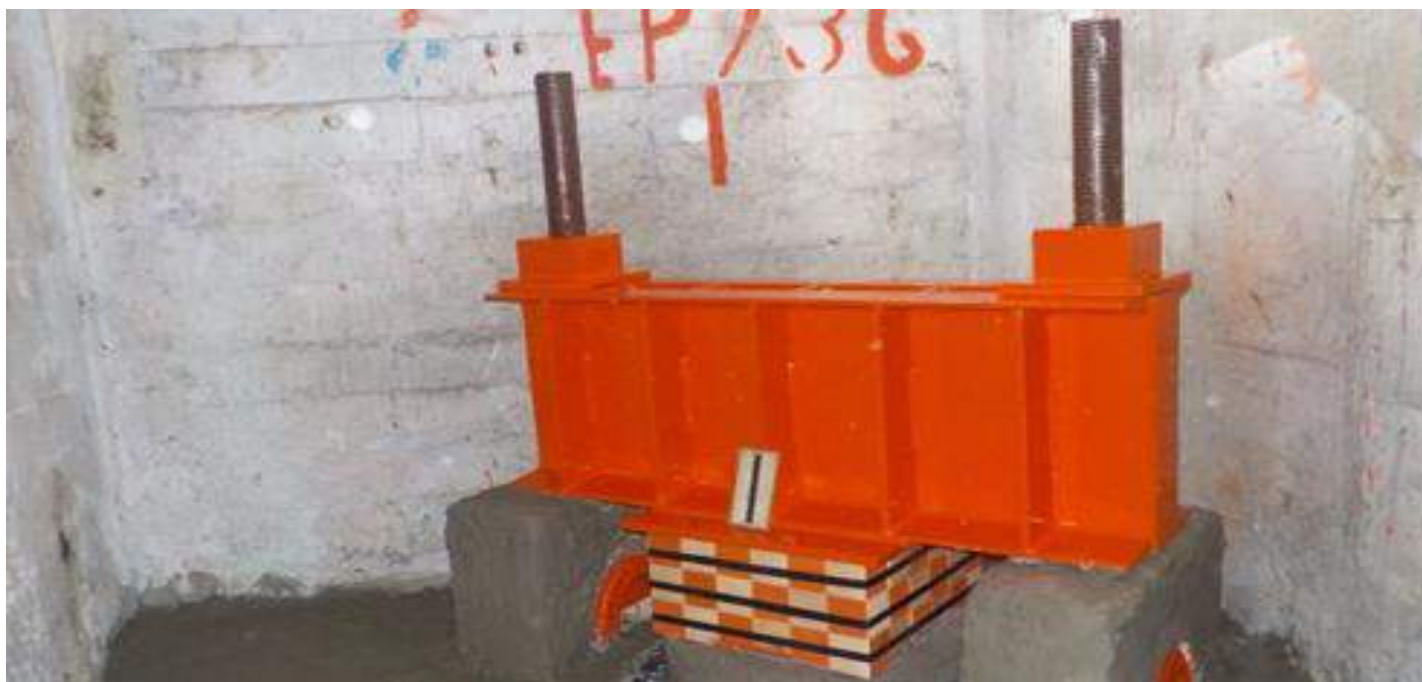
"Reparación de pilote de control"
