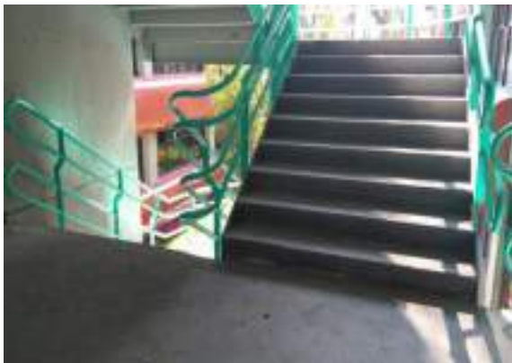
Adecuación en cubos de escaleras
