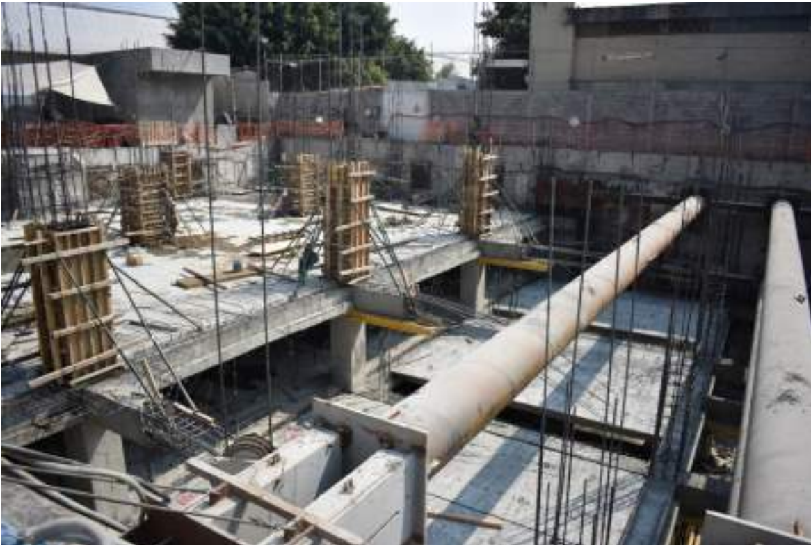
La colocación de troqueles metálicos que cruzan el terreno brindan estabilidad a las cimentaciones vecinas
