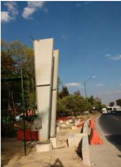
Columna se apoyo
