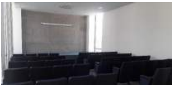
Colocación de butacas en Auditorio
