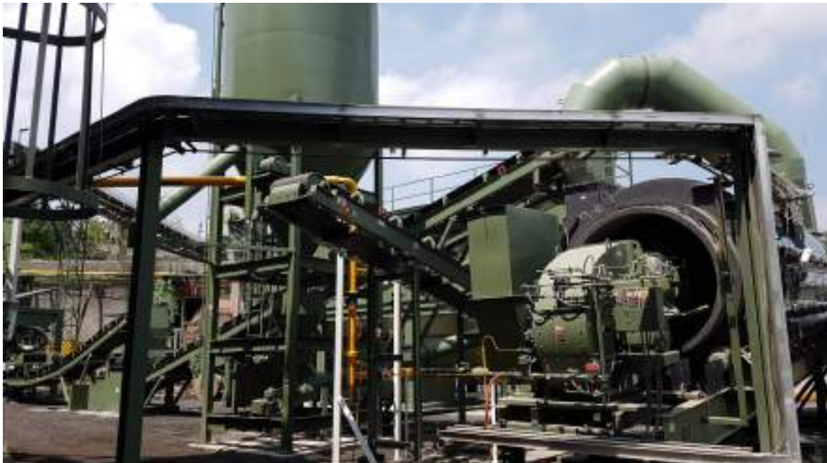
Vista de la Planta de Asfalto Nueva
