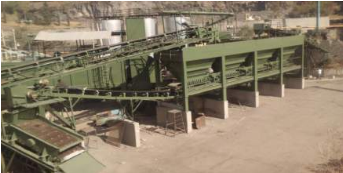
Tolvas, transportadores y cribas terminados
