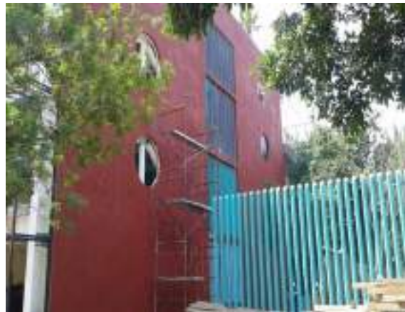
Colocación de tubería para confinamiento perimetral
