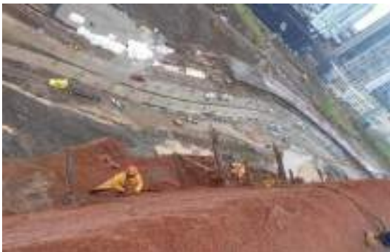
Trabajos de perfilado del talud
