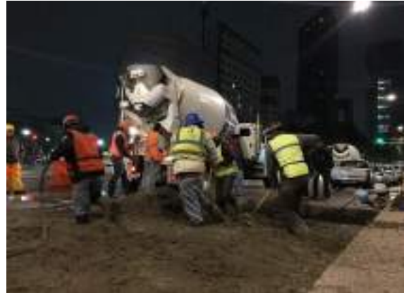
Vaciado de concreto hidráulico
