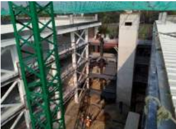
Vista panorámica de la estructura metálica
