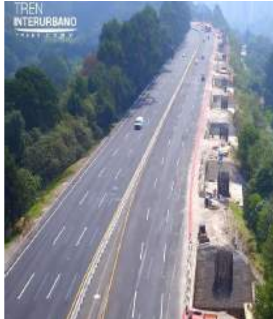
Trabajos de cimentación
