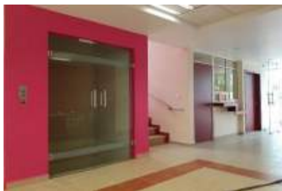
Colocación de puerta de cristal
