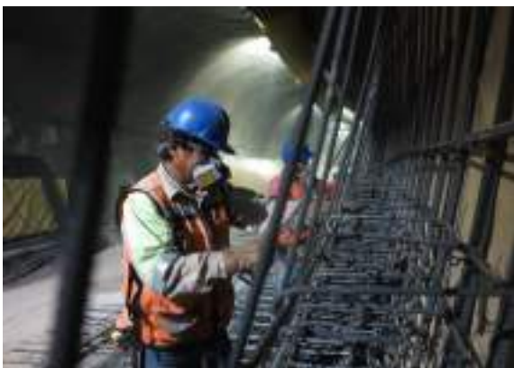
Habilitación de acero en muros
