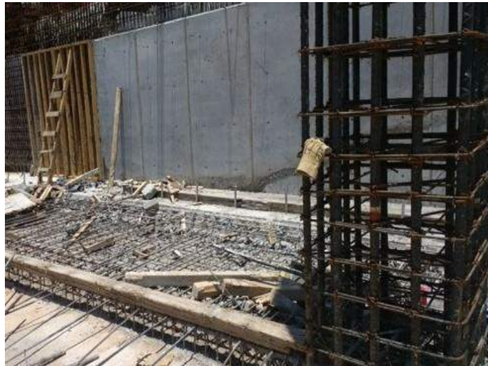
Armado de acero en losa inferior
