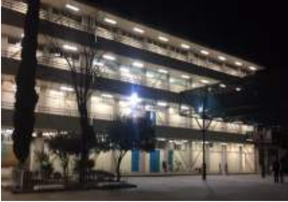
Colocación de luminarias y reflectores
