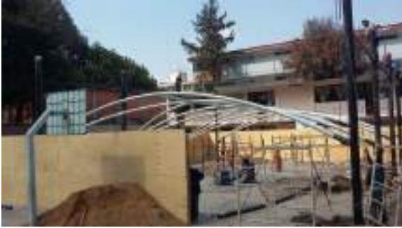
Estructura de soporte para cubierta
