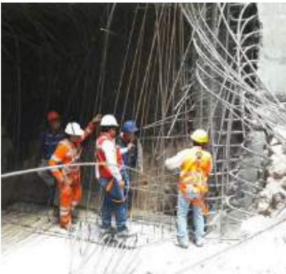
Armado de refuerzo en paredes
