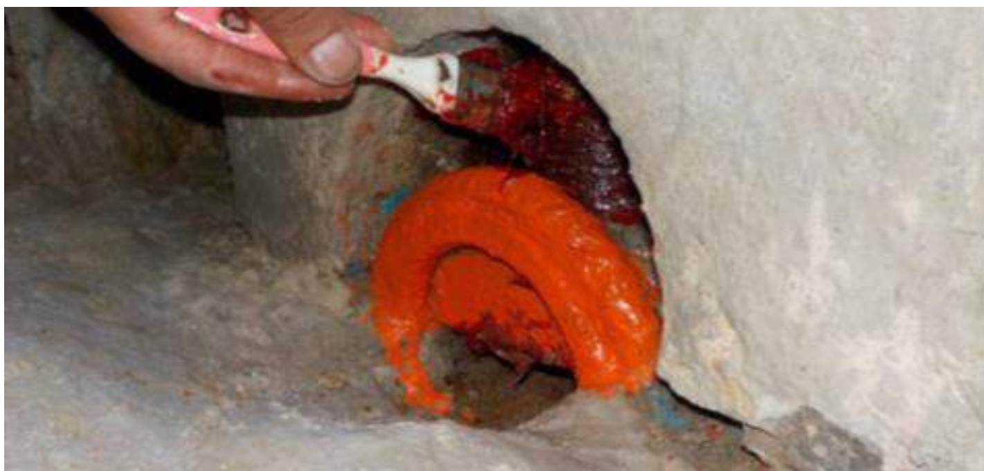
"Aplicación de grasa en partes metálicas"
