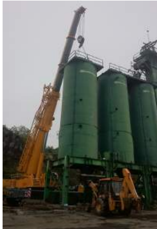
Retiro de silos de almacenamiento Planta No. 7
