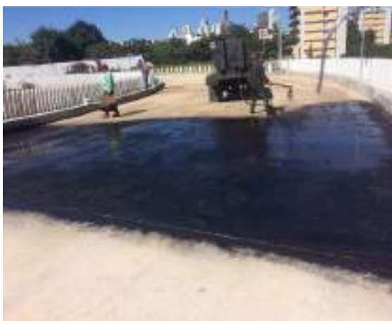
Aplicación de riego asfáltico
