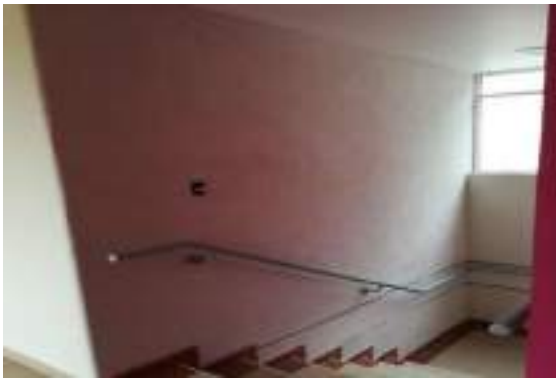
Instalación de barandal en escalera
