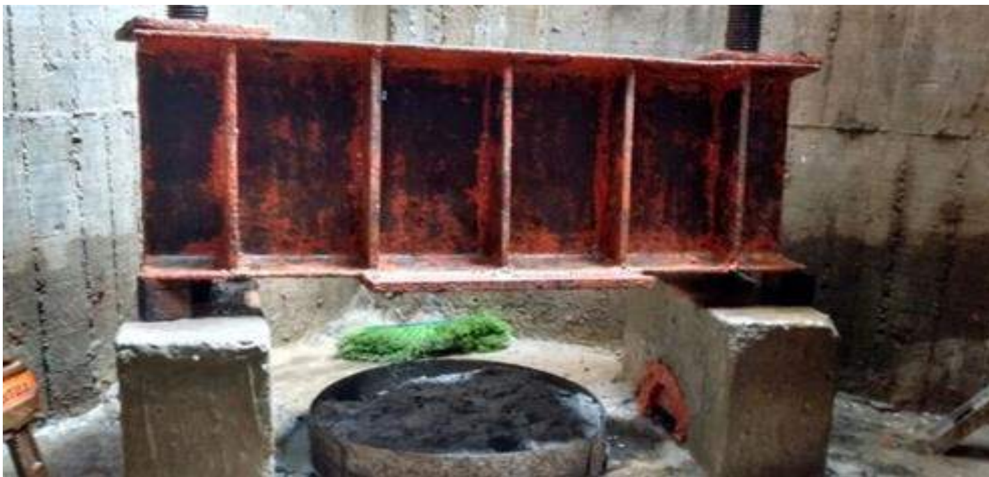
"Mantenimiento del pilote de control"
