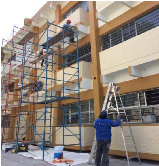
Suministro y aplicación de pintura en exteriores
