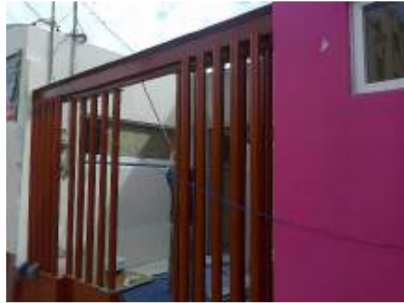
Instalación de puerta de acceso principal
