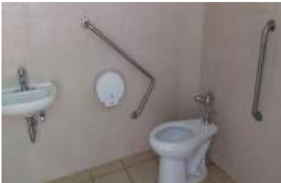
Rehabilitación de instalaciones sanitarias
