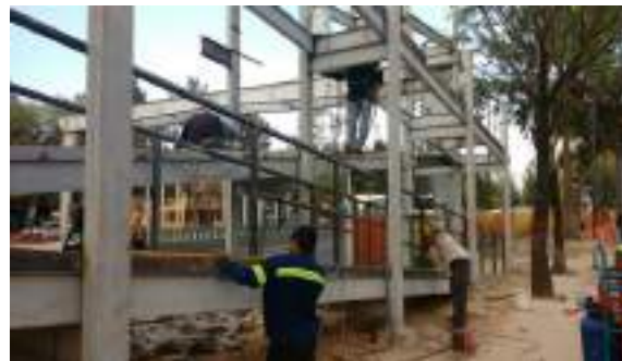
Colocación de rampas metálicas
