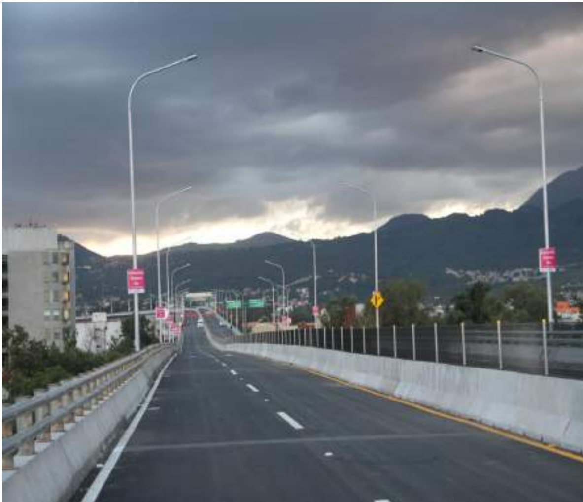
Elementos de protección (parapetos metálicos y de concreto)
