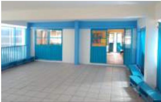
Suministro y aplicación de pintura en herrería
