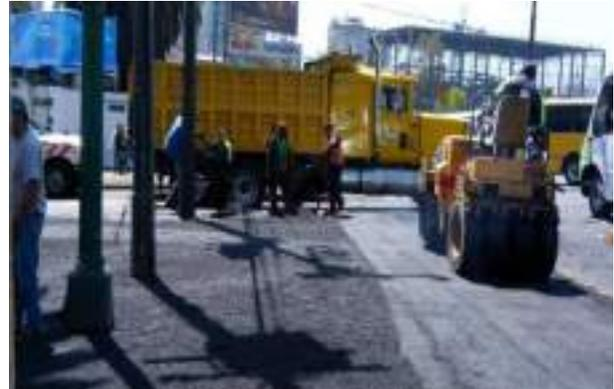
Compactación de tendido de la mezcla asfáltica
