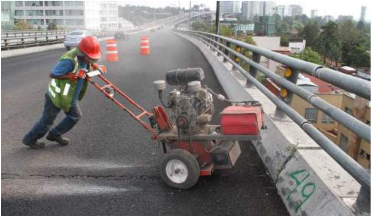
Corte de carpeta asfáltica para demolición de junta
