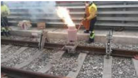
Aplicación de soldadura aluminotérmica
