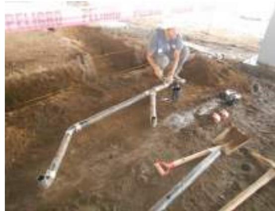
Tendido de tubería, instalación sanitaria.
