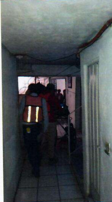
Adquisición RPT, casas dañadas 2
