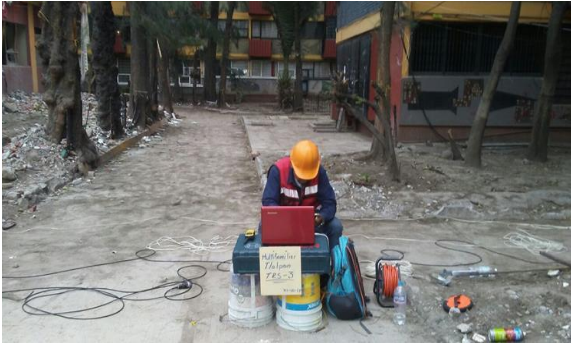
FOTOGRAFÍA 8. VISTA GENERAL DE LA UBICACIÓN INICIAL DEL TRS-3, ASÍ COMO DE LA ADQUISICIÓN DE DATOS DE TIPO GEOSÍSMICO.
