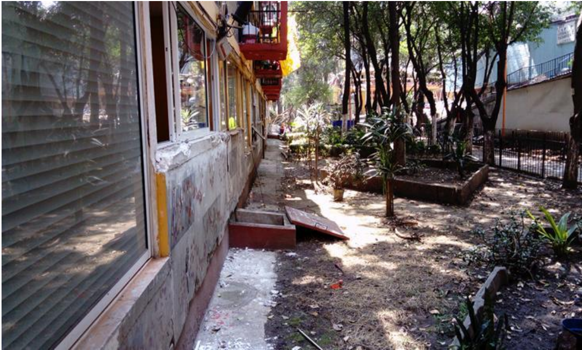
FOTOGRAFÍA 1. VISTA GENERAL DE LAS CONDICIONES DEL PREDIO AL INTERIOR DEL MISMO.
