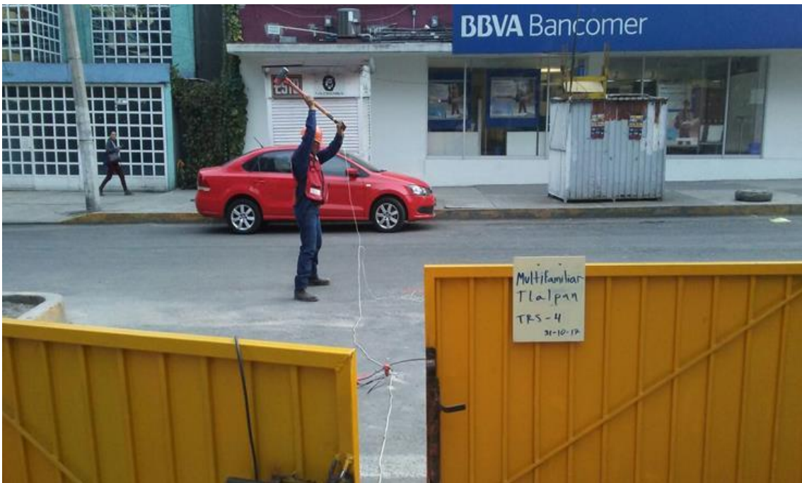
FOTOGRAFÍA 11. GENERACIÓN DE FRENTE DE ONDA EN EL EXTREMO FINAL DEL TRS-4., UBICADO SOBRE LA CALLE ÁLVARO GÁLVEZ Y FUENTES.
