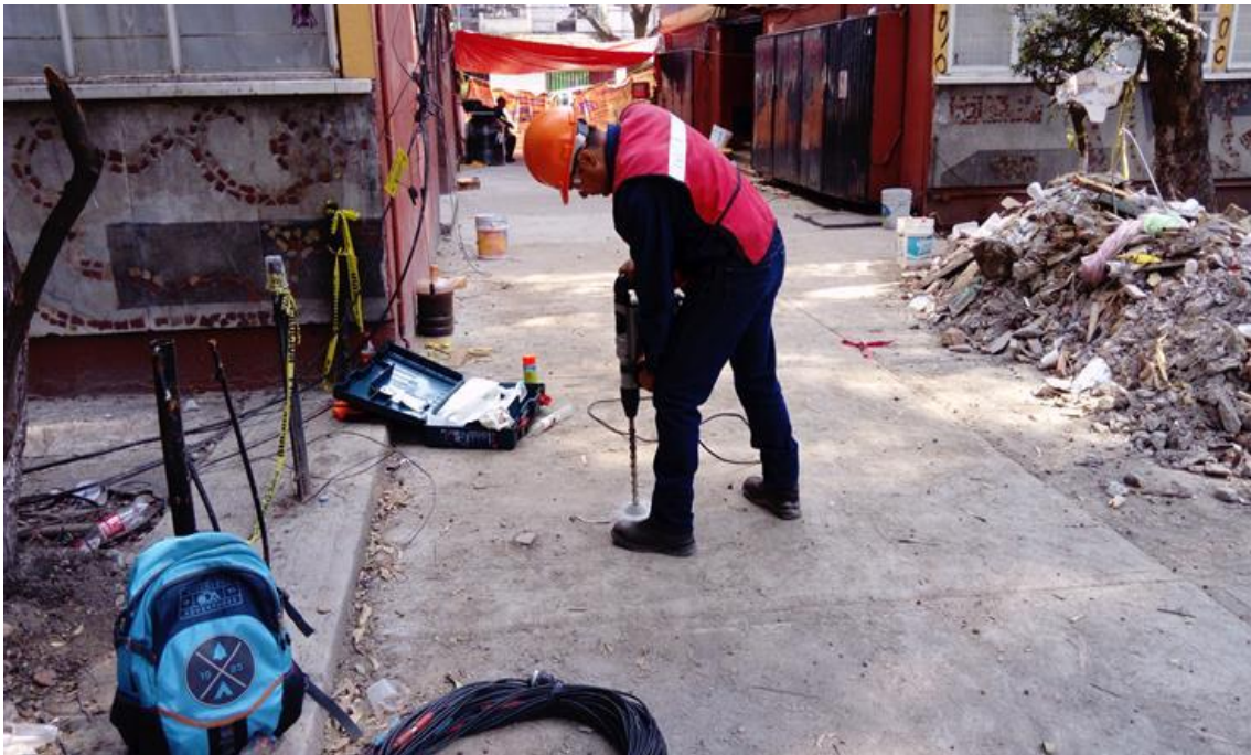
FOTOGRAFÍA 3. PERFORACIÓN PREVIA A LA ADQUISICIÓN DE DATOS GEOSÍSMICOS EN EL TRS-1.
