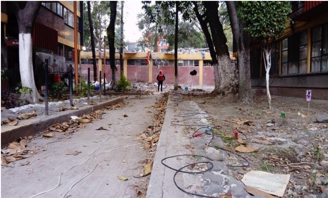
FOTOGRAFÍA 10. VISTA GENERAL DEL TRS-4, DONDE SE OBSERVA EL CABLE SÍSMICO Y LOS GEÓFONOS, TENIENDO DE FONDO EL EDIFICIO COLAPSADO.
