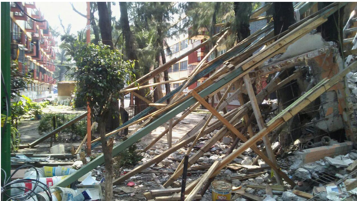
FOTOGRAFÍA 13. VISTA LATERAL DEL APUNTALAMIENTO SOBRE EL EDIFICIO COLAPSADO.
