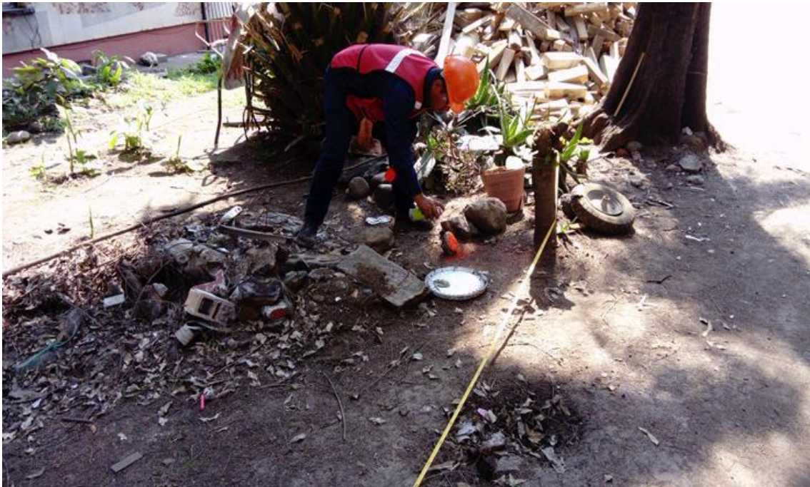
FOTOGRAFÍA 2. MEDICIÓN Y MARCADO PARA EL HINCADO DE GEÓFONOS EN EL TRS 1.
