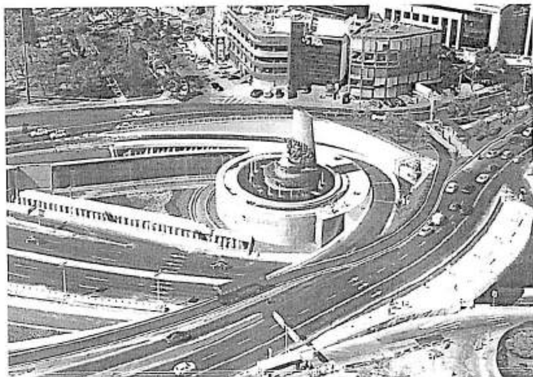
Figura II.77 Estación Fuente de Petróleos.
