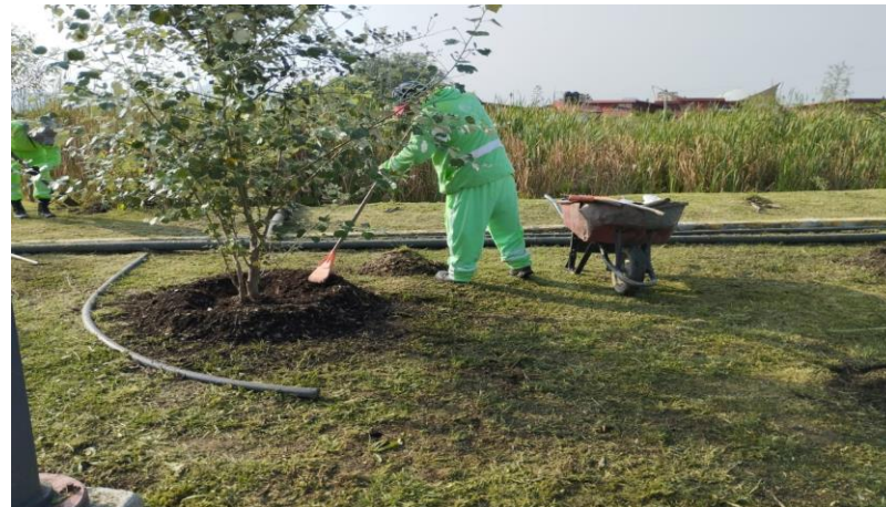
CONSTRUCCIÓN DE CAJETE
