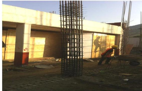
Habilitado y armado de acero para columnas
