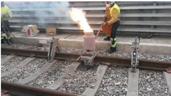
Aplicación de soldadura aluminotérmica
