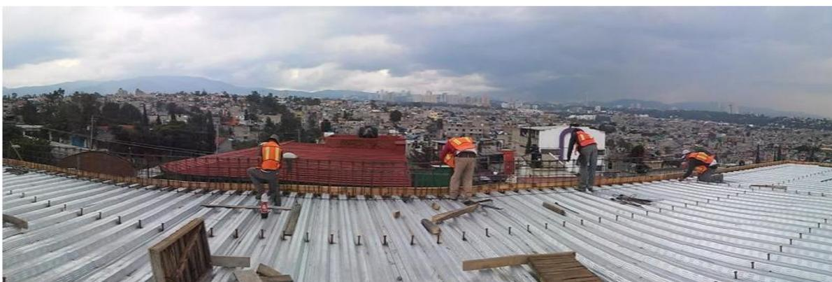
Armado de pretil con acero de refuerzo
