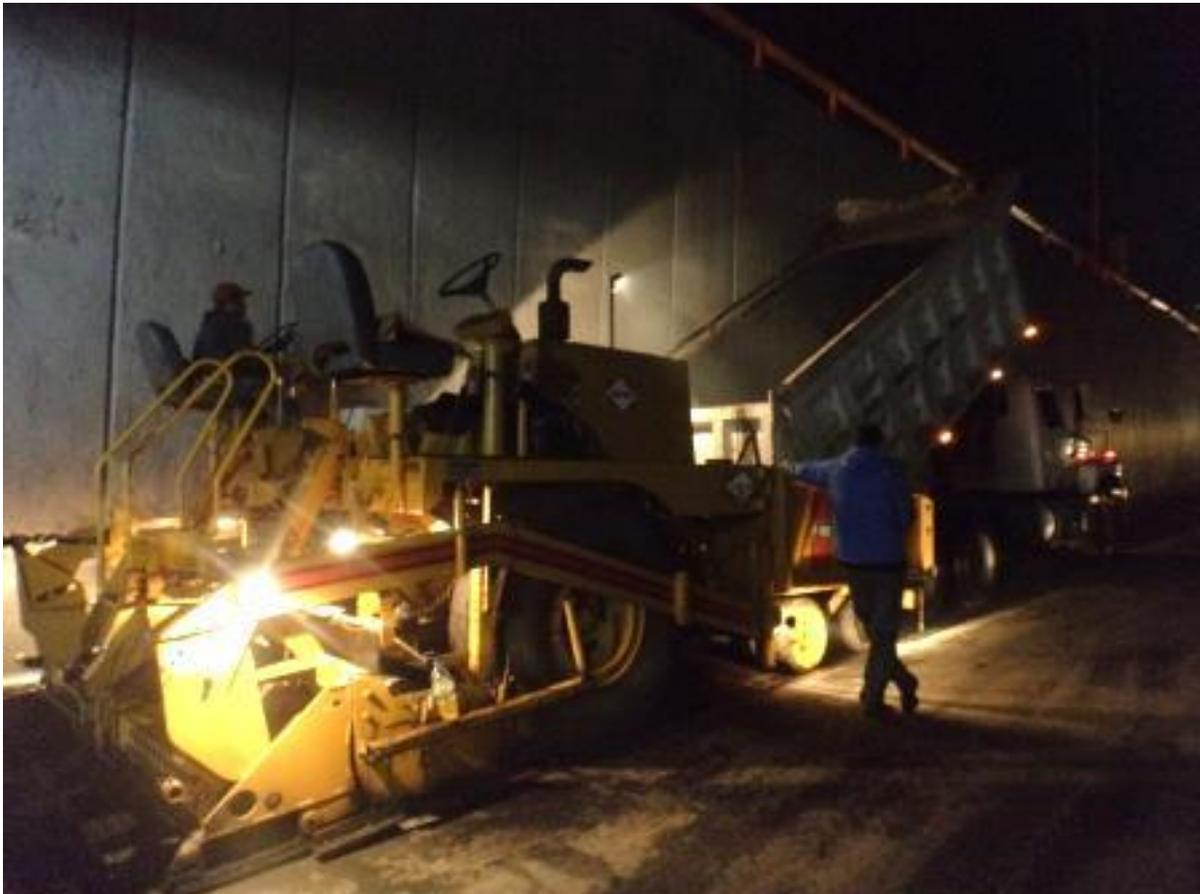
Tendido de mezcla asfáltica en caliente
