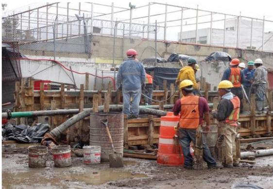
Colado de concreto de juntas constructivas
