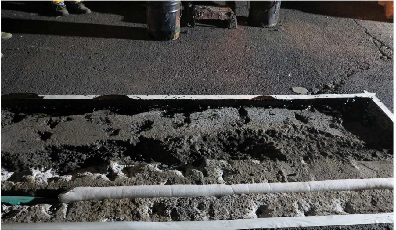
Colocación de mezcla aglutinante polimérica en caliente a base de gravas y arenas
