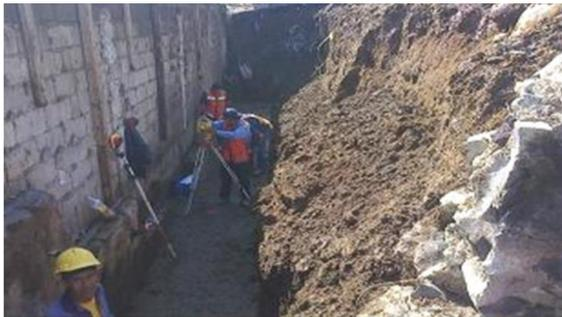
Trazo topográfico, para muro de contención
