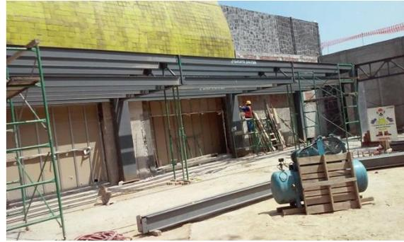
Colocación de estructura metálica para pórtico
