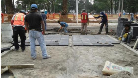
Construcción de piso de adoquín gris martelinado
