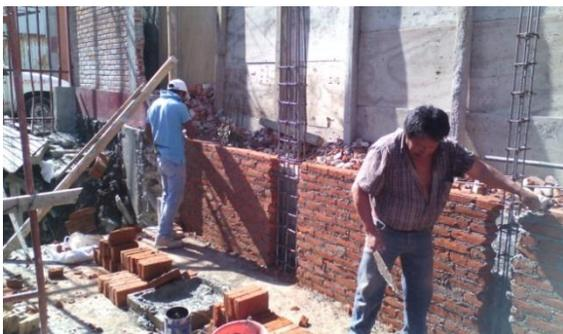
Construcción de muros de tabique
