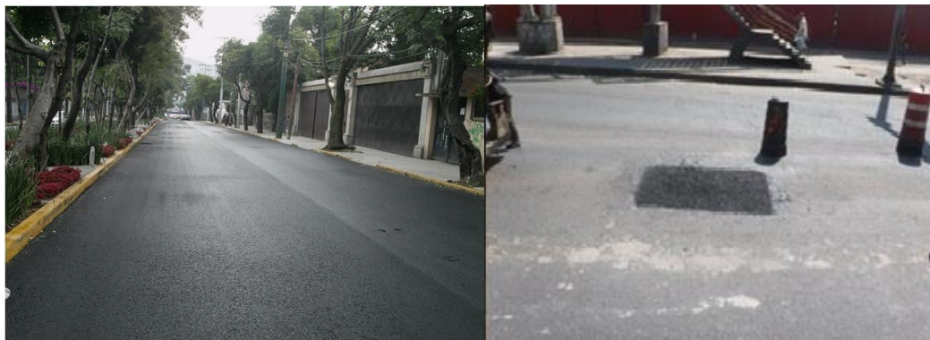
Repavimentación y Bacheo
