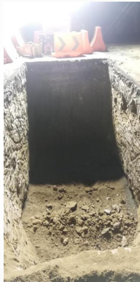
Corte y demolición de carpeta asfáltica y retiro de material producto de excavación (horario nocturno).
