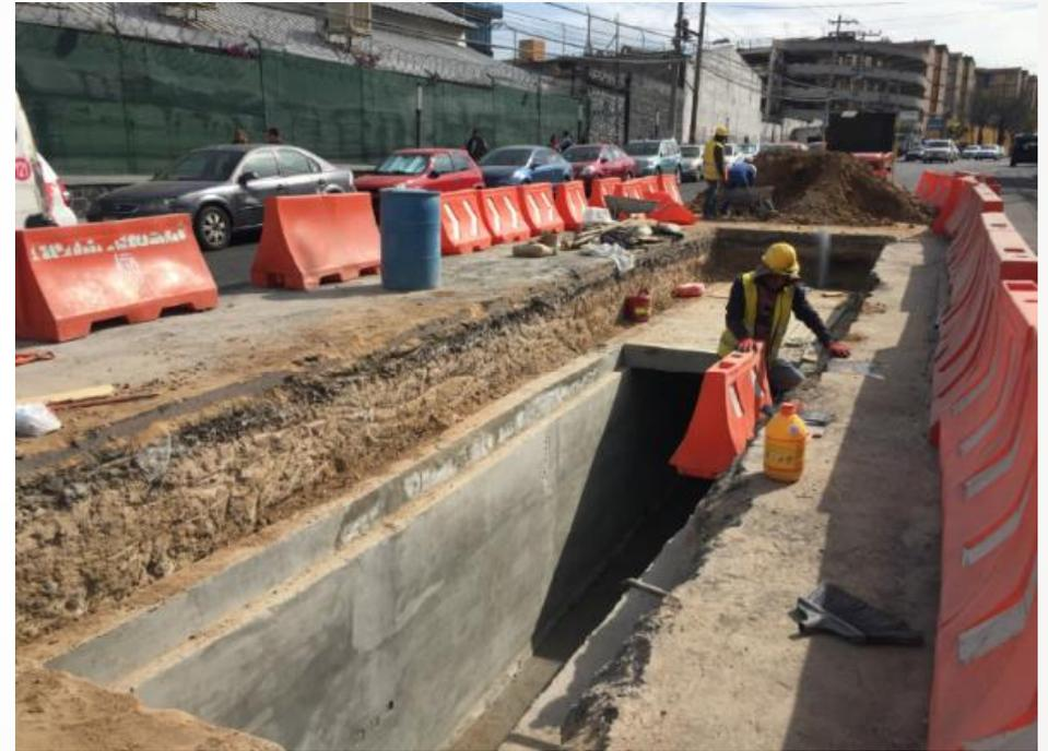
Descimbrado y colocación de tapas en fosa.
