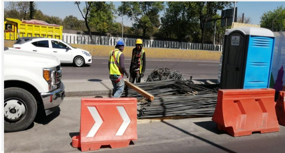
Se encuentra en el proceso de cimbrado, seguido de el armado de acero; para posteriormente poder llevar a cabo el colado con concreto.
