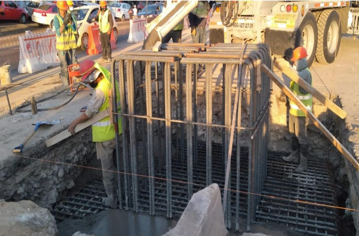
Proceso de colado de zapata en apoyo 179
