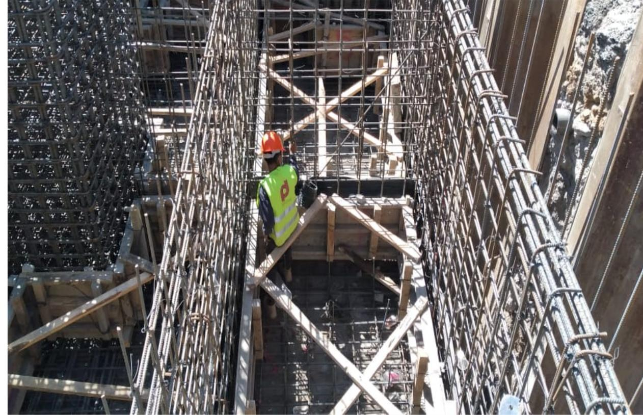
Armado de cajón de cimentación apoyo 112
