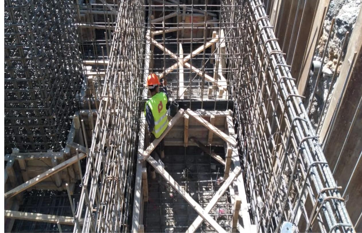
Armado de cajón de cimentación apoyo 112
