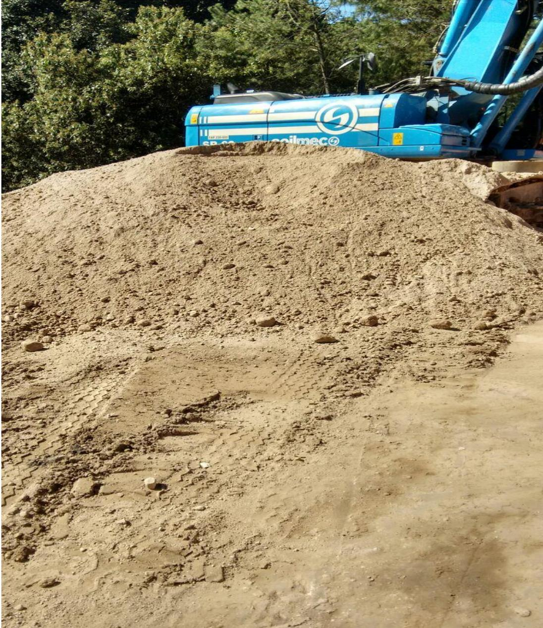
Foto 39. Vista del material excavado a 45 m de profundidad.
