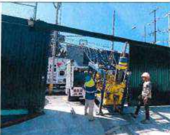
Foto No. 1.11 Retiro del equipo de perforación del sitio de estudio.
