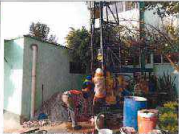
Foto No. 1.2 Exploración y muestreo del sondeo mecánico directo SPT-8
