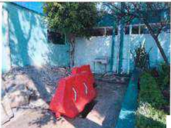
Foto No. 1.10 Recondicionamiento del sitio.
