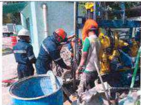
Foto No. 1.9 Ejecución de prueba de Phicómetro dentro del sondeo SAC-8A
