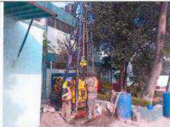
Foto No. 1.8 Exploración del subsuelo con el sondeo mecánico directo SAC-8A
