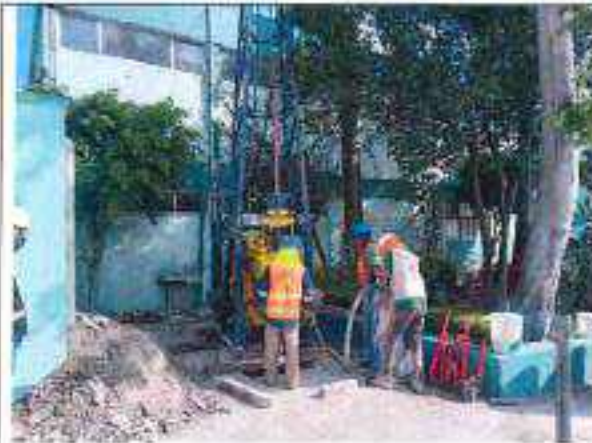
Foto No. 1.7 Instalación del equipo de perforación en el punto del sondeo SAC-8A.
