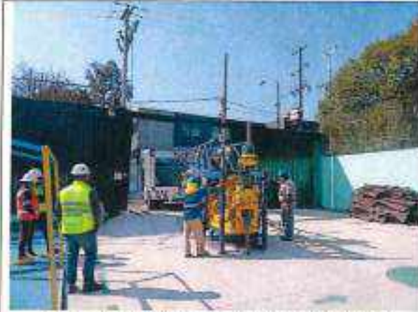
Foto No. 1.1 Instalación del equipo de perforación en el punto del sondeo SPT-8.
