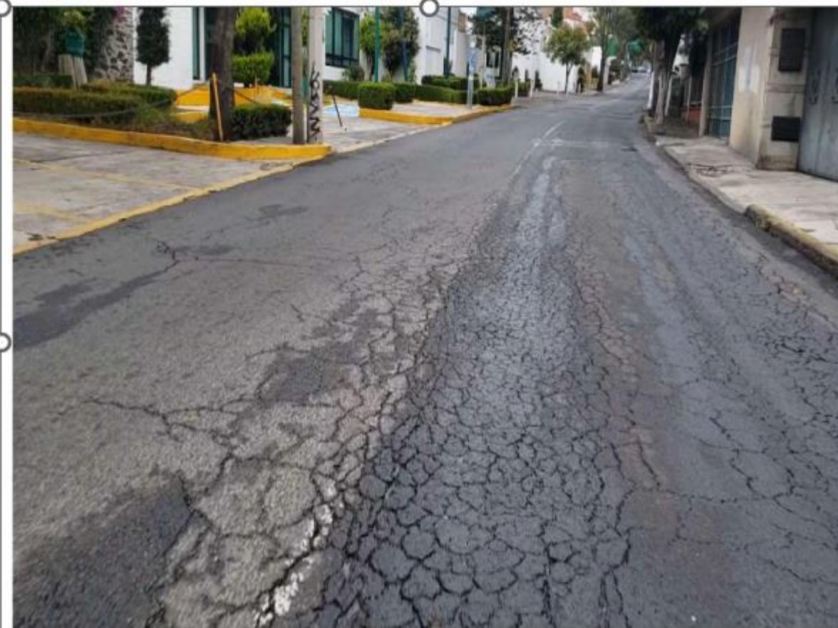
Agrietamiento en bloque
