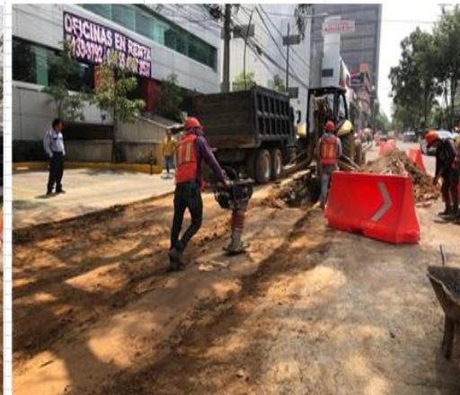
SE REALIZA RELLENO COMPACTÓ CON MATERIAL DE BANCO TEPETATE EN CAPAS DE 20 CM.
