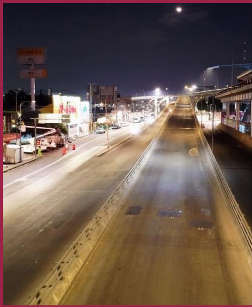
DISTRIBUIDOR VIAL LA CONCORDIA
