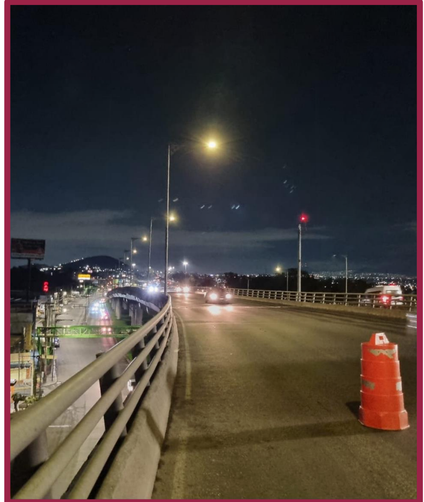
DISTRIBUIDOR VIAL LA CONCORDIA
