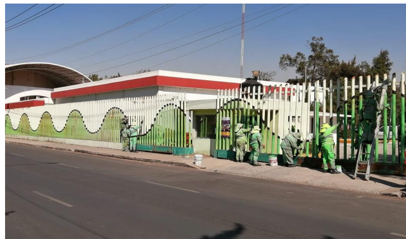
APLICACIÓN DE PINTURA
