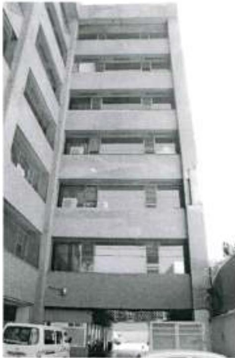
*Ilustración 2 Desprendimiento del recubrimiento de la fachada, dejando expuesto tabique rojo*
