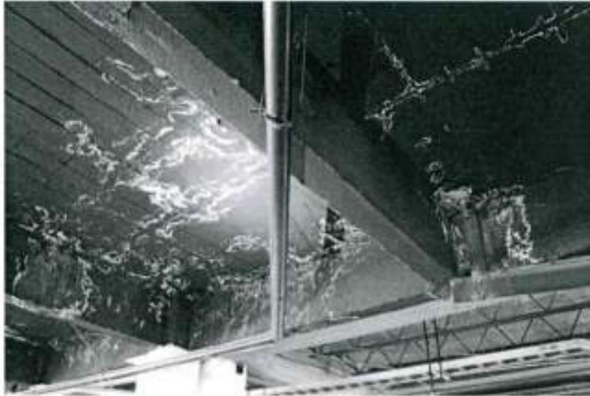
*Ilustración 4 Humedad en la losa tapa del sótano*
