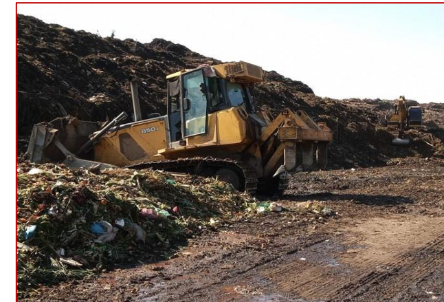
Empuje de residuos para conformación de pilas
