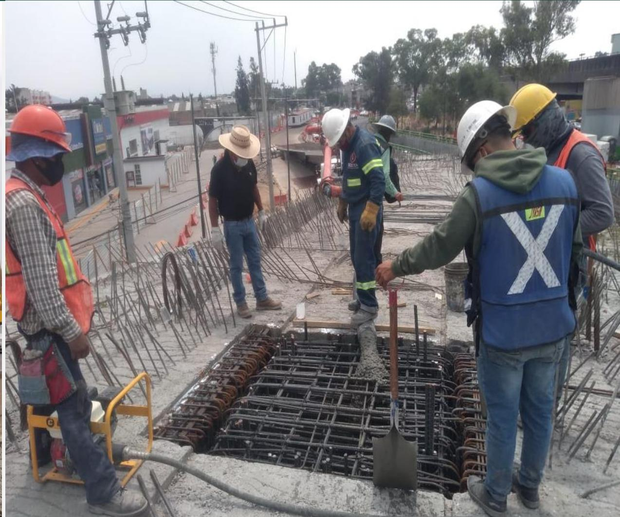
**Colado de nodos de conexión entre columna y trabe**
