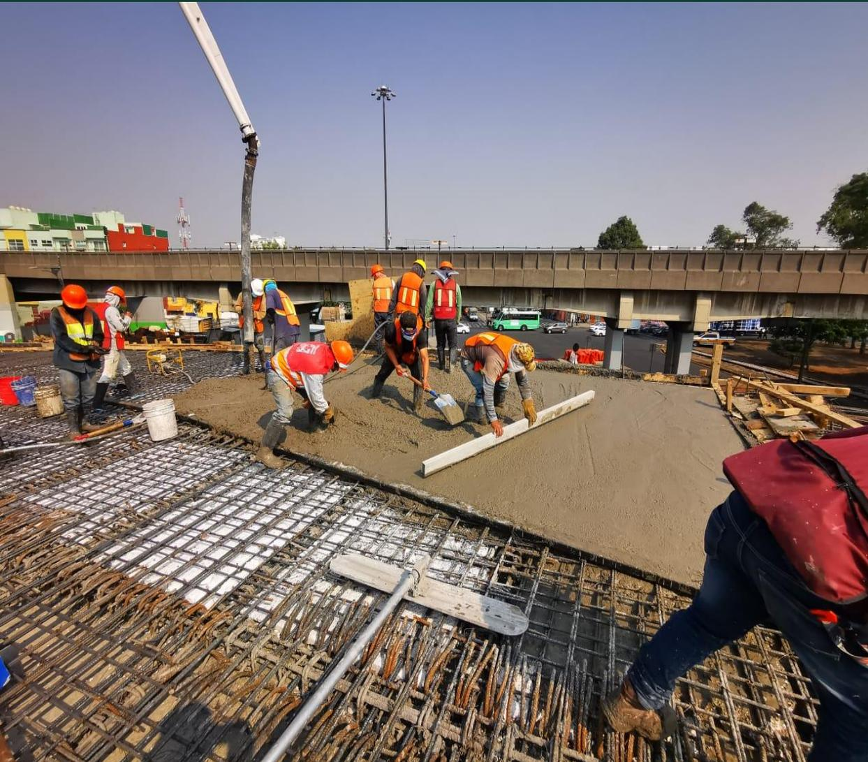
**Armado y colado de superficie de rodamiento con concreto hidráulico**
