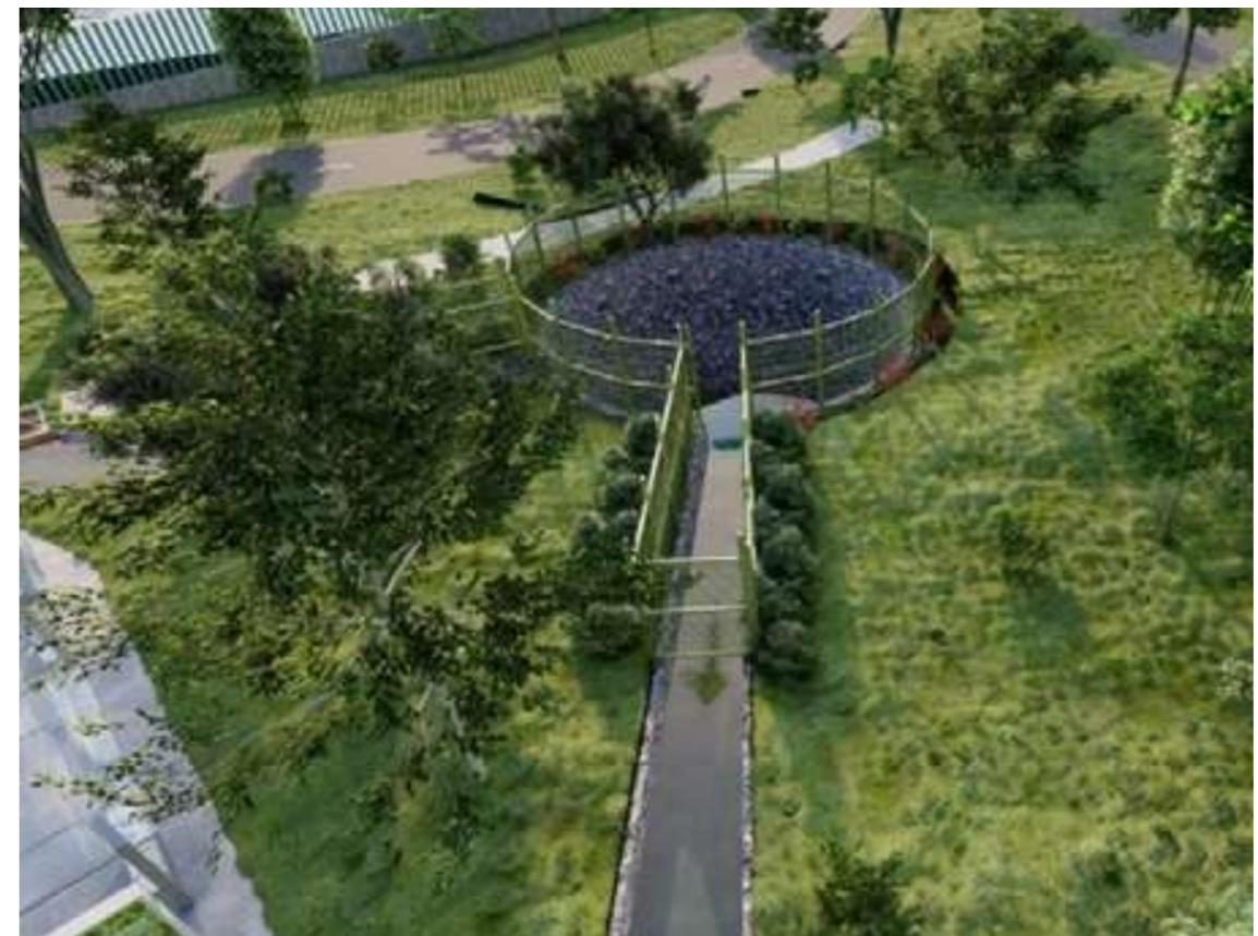
Sumidero de infiltración de agua pluvial
