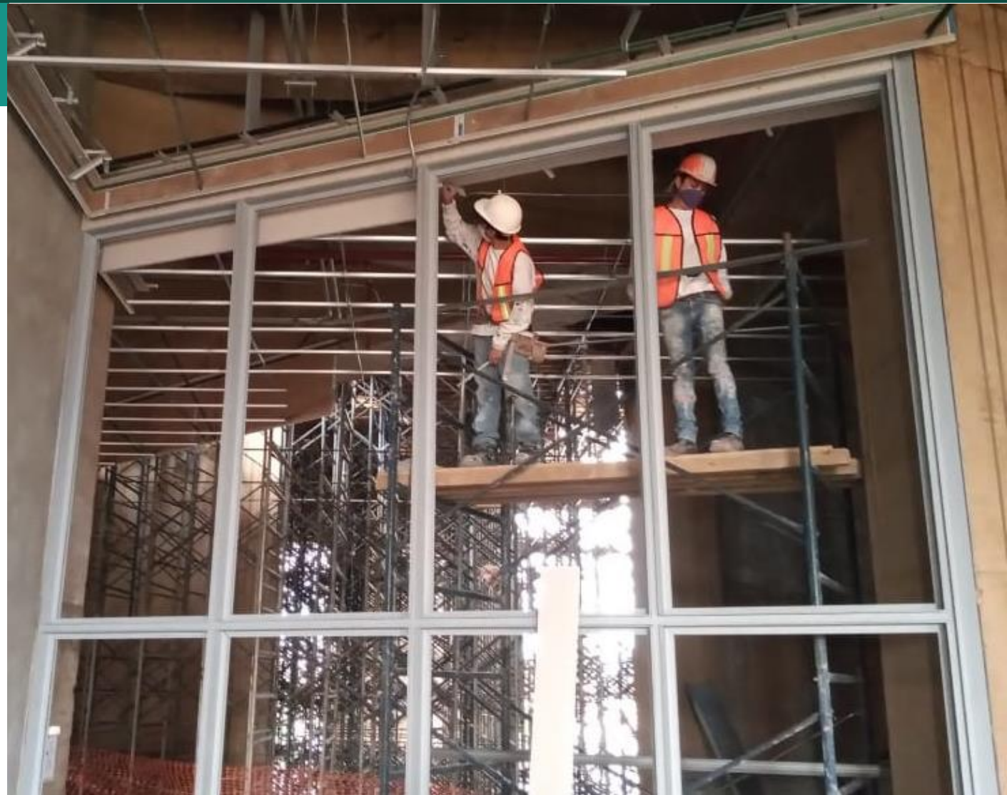
Aplicación de pintura
