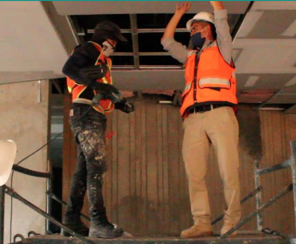
Colocación de los soportes para plafones
