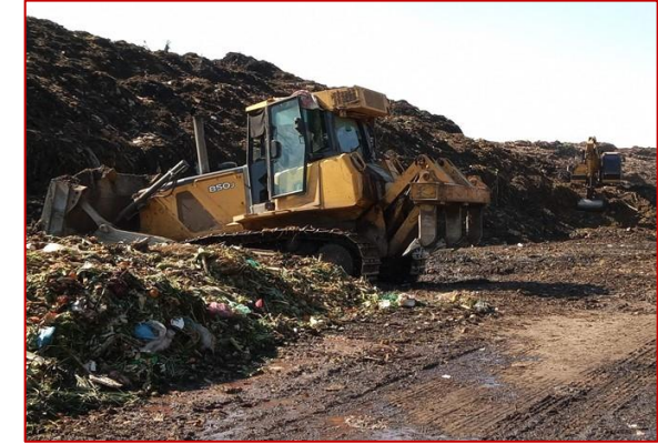
Empuje de residuos para conformación de pilas
