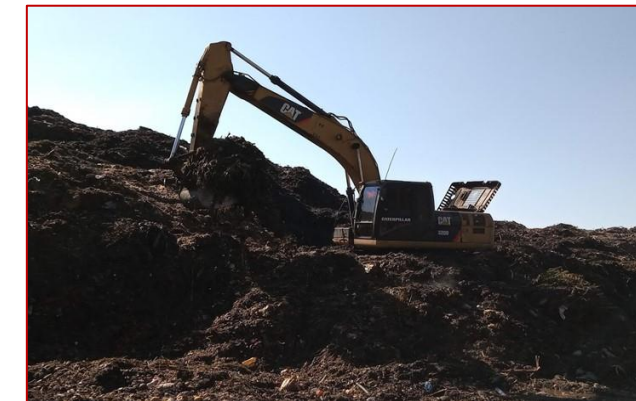
Empuje y movimiento de material para aireación , *
