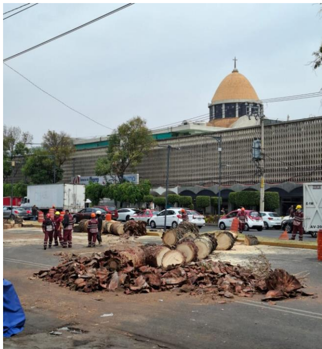
DERRIBO DE PALMERAS
