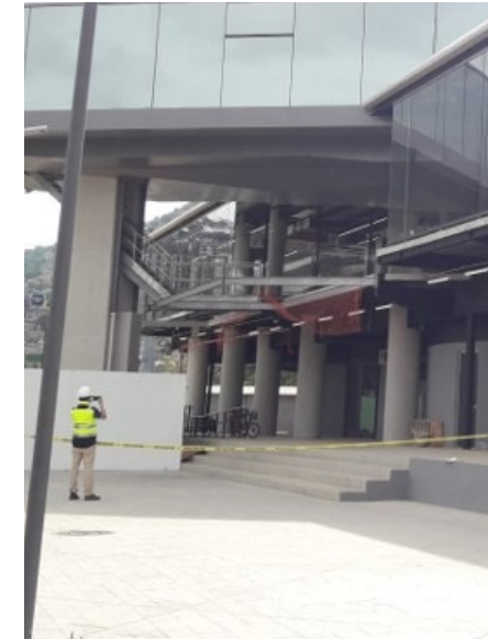
4. Albañilerías, acabados e instalaciones
