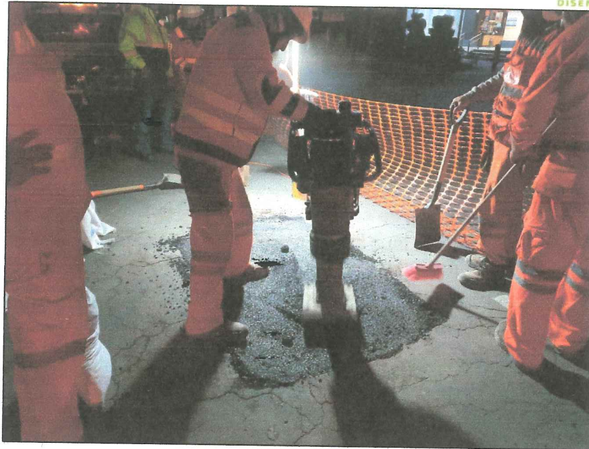
Figura 2.4. Relleno y compactación del PCA
