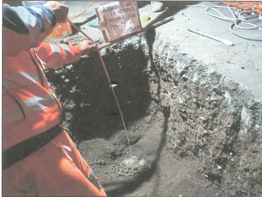
Figura 2.2. Vista de la losa de concreto armado, fin del PCA
