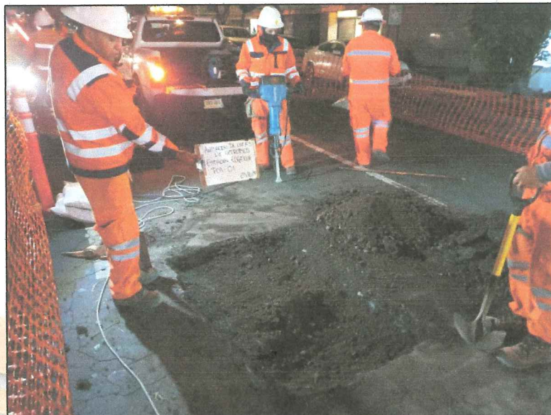
Figura 2.1. Vista de la excavación y muestreo de los materiales encontrados
