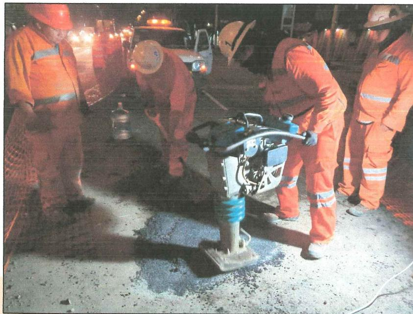
**Figura 2.4. Relleno del PCA y compactación del material asfáltico**
