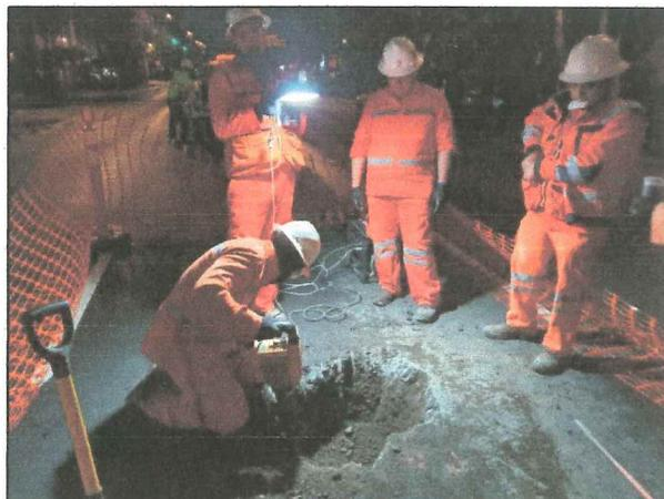
**Figura 2.2. Remoción de la carpeta asfáltica y excavación del PCA**
