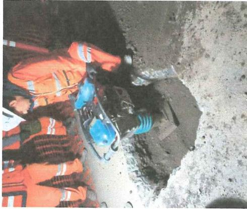
Figura 6. Colocación de asfalto en el PCA-01
