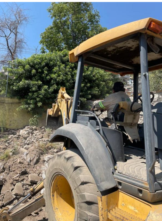
1.- Limpieza de los RCD en el campamento por parte de los trabajadores de la alcaldía
