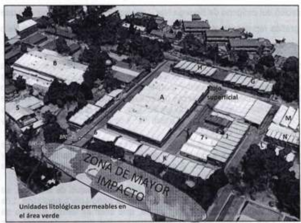
Figura 25. Flujo superficial desde los edificios industriales con cubiertas de concreto pendiente arriba y la zona de mayor impacto compuesta por terreno natural pendiente abajo.
