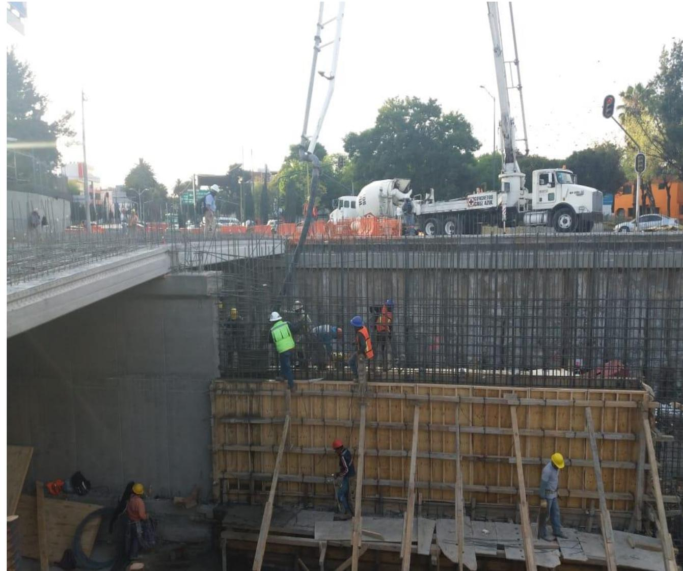
Armado de losa de compresión y colado de **muro central**
