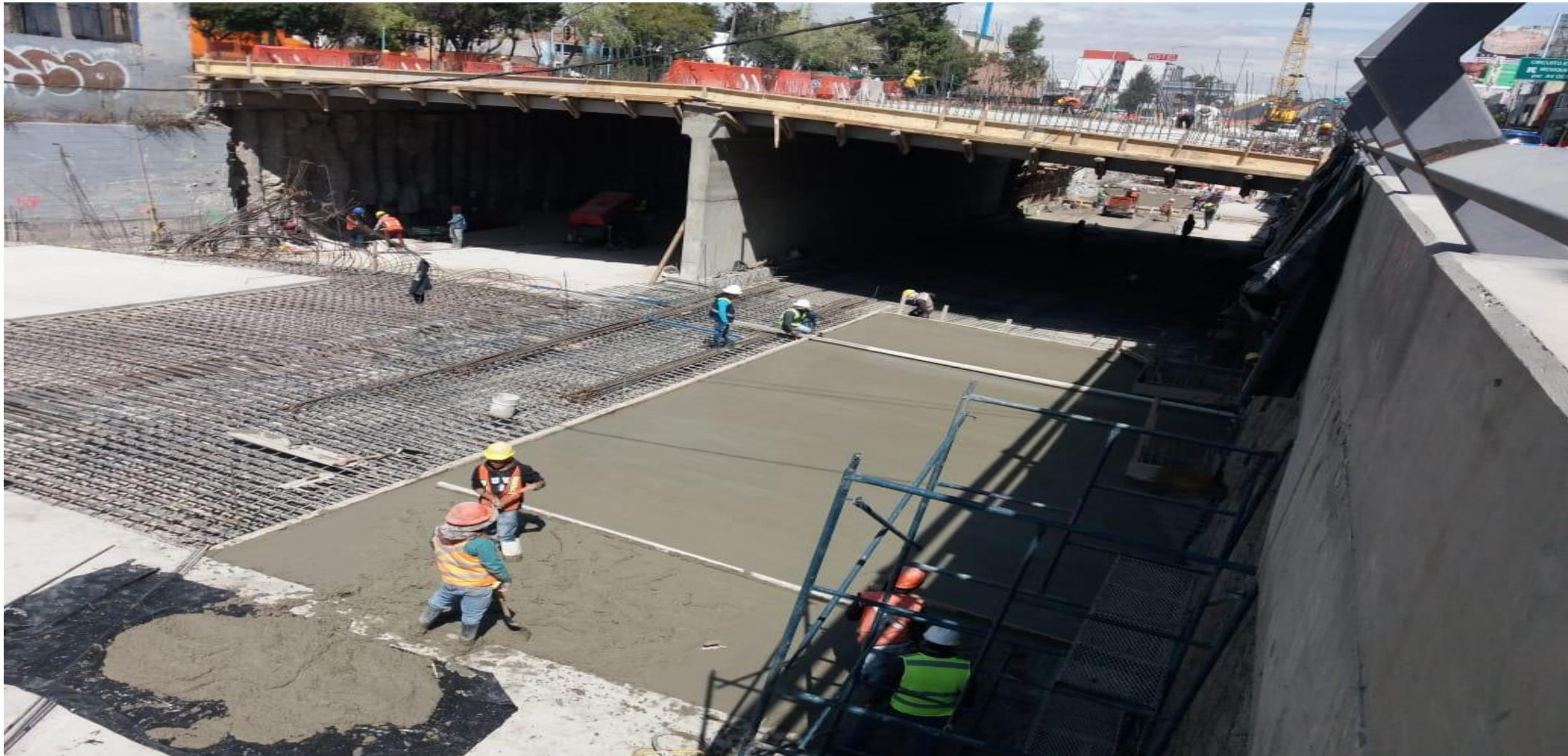
Armado y colado de losa de rodamiento inferior
