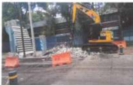
Demolición de escaleras y columnas
