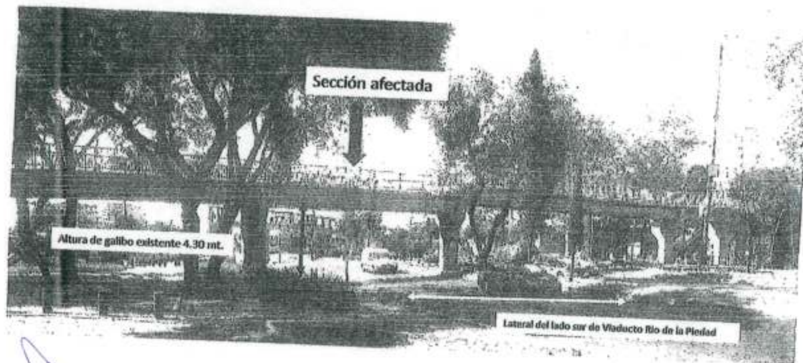
Imagen-3 Vista Lateral Del Puente.
