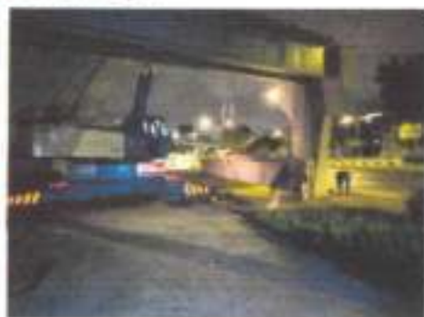
Maniobras de desmontaje de traves
