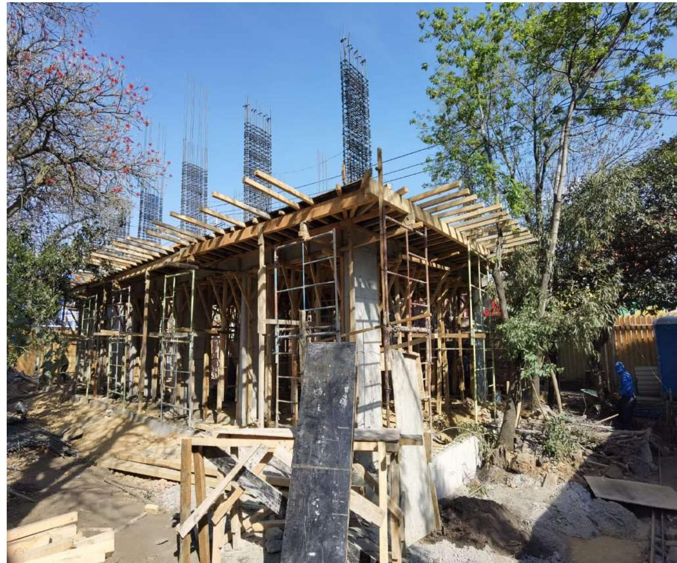
Fabricación de elementos estructurales en concreto reforzado
