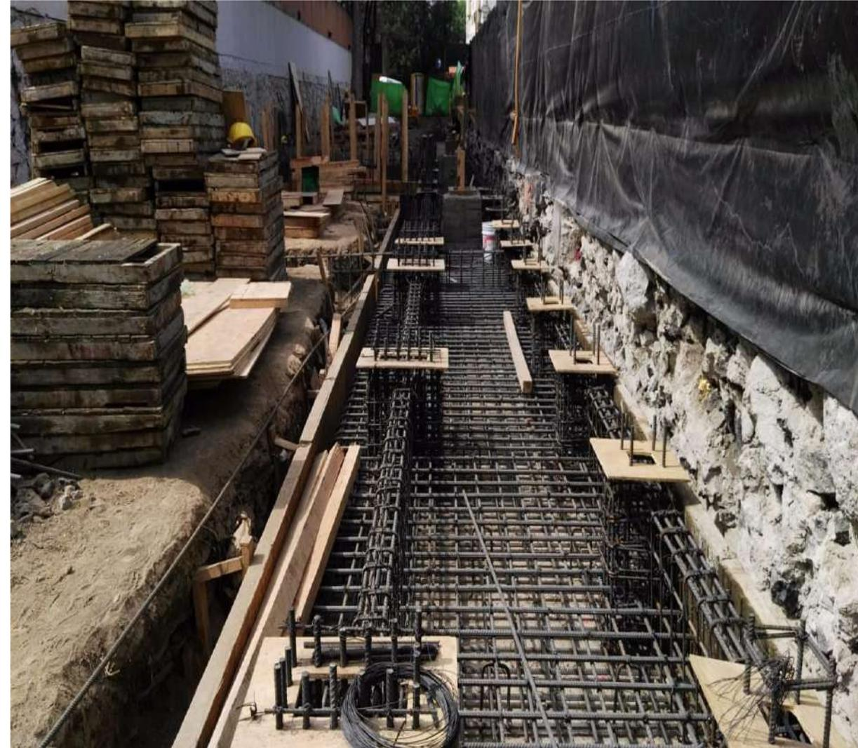
Habilitado y colocación de acero de refuerzo para la cimentación
