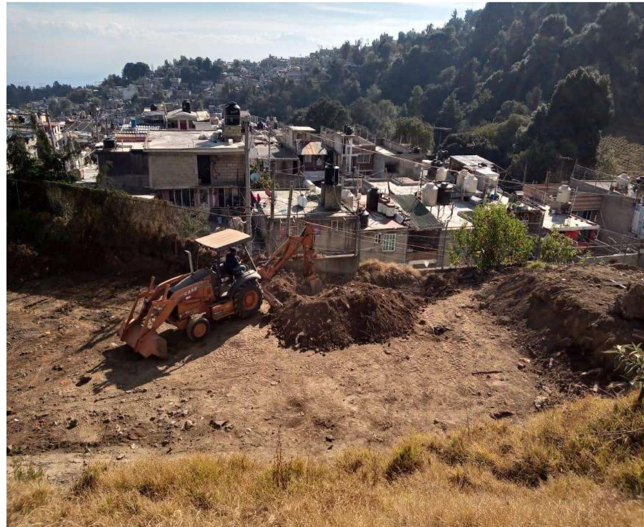
Excavación para desplante de la cimentación
