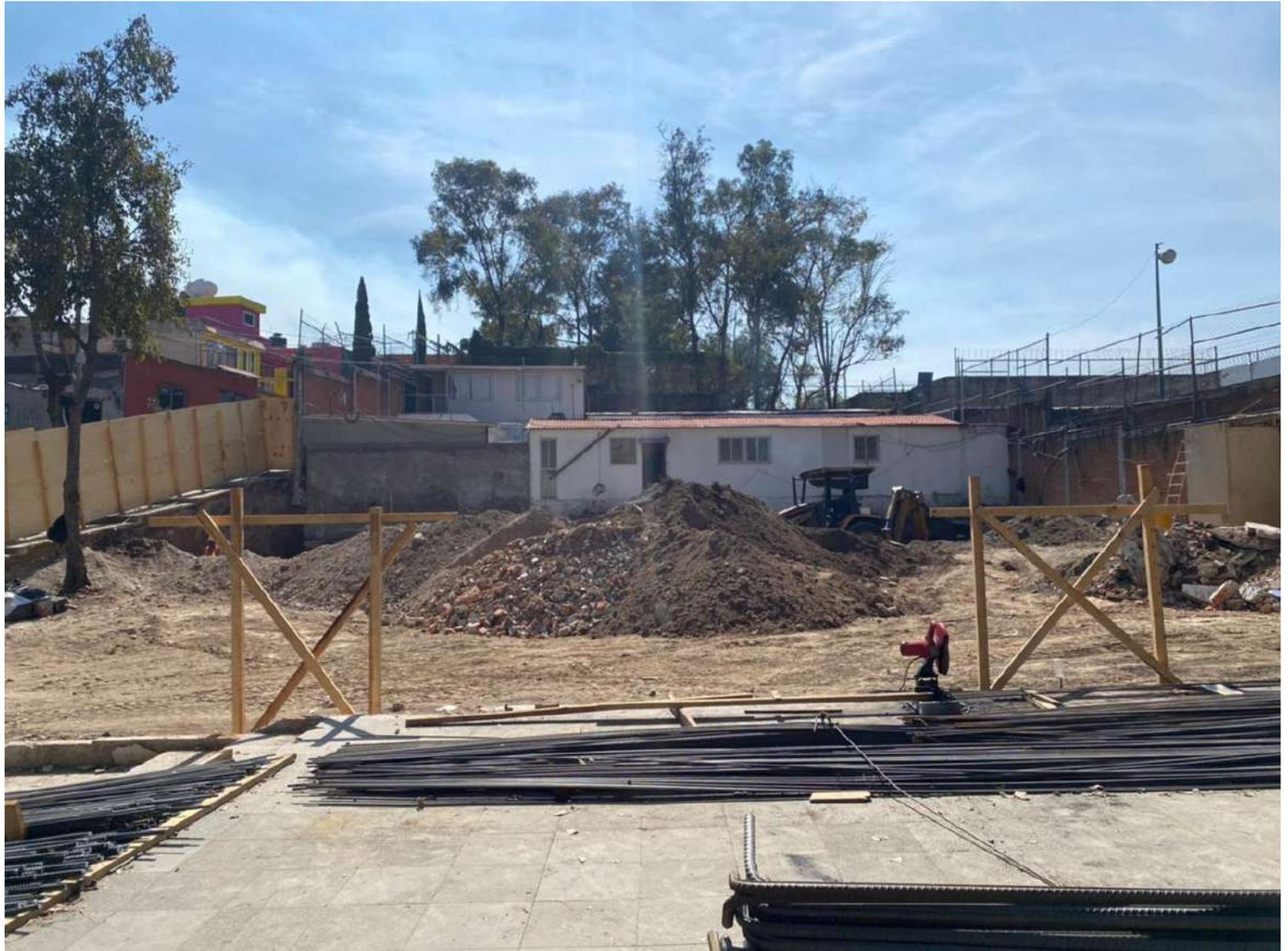
Excavaciones y habilitado de acero de refuerzo para la cimentación
