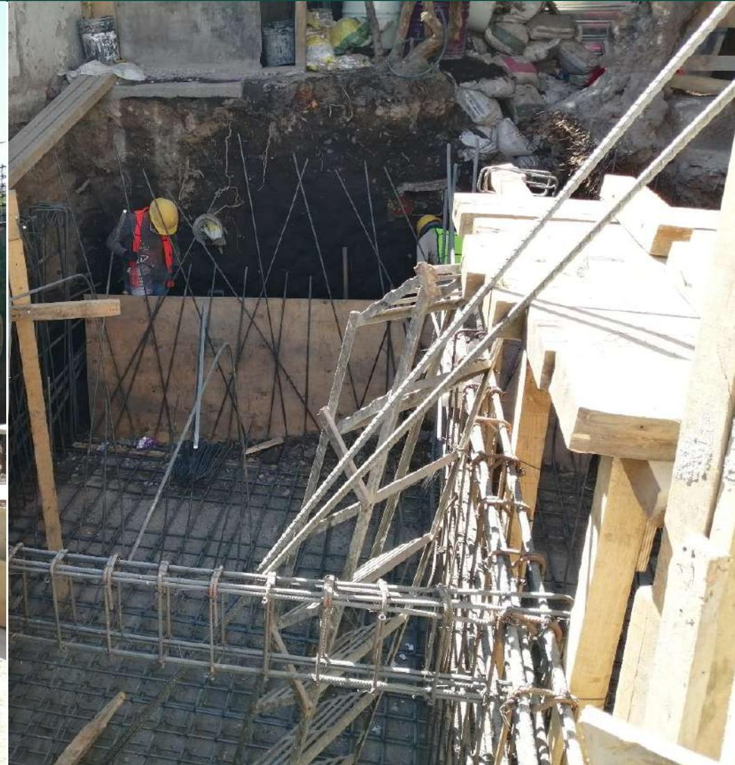
Habilitado de acero de refuerzo para muros de concreto
