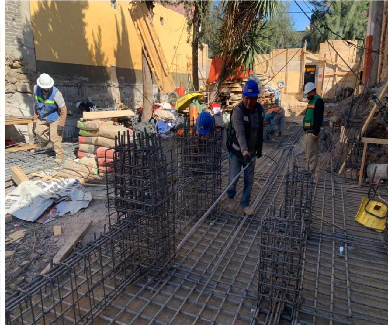
Habilitado y colocación de acero de refuerzo para la cimentación
