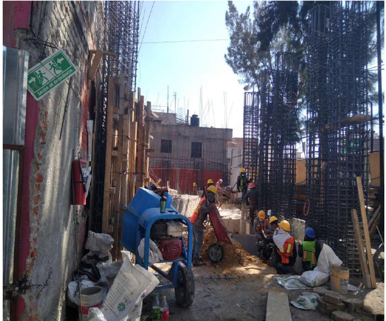
Habilitado de acero de refuerzo para muros de concreto
