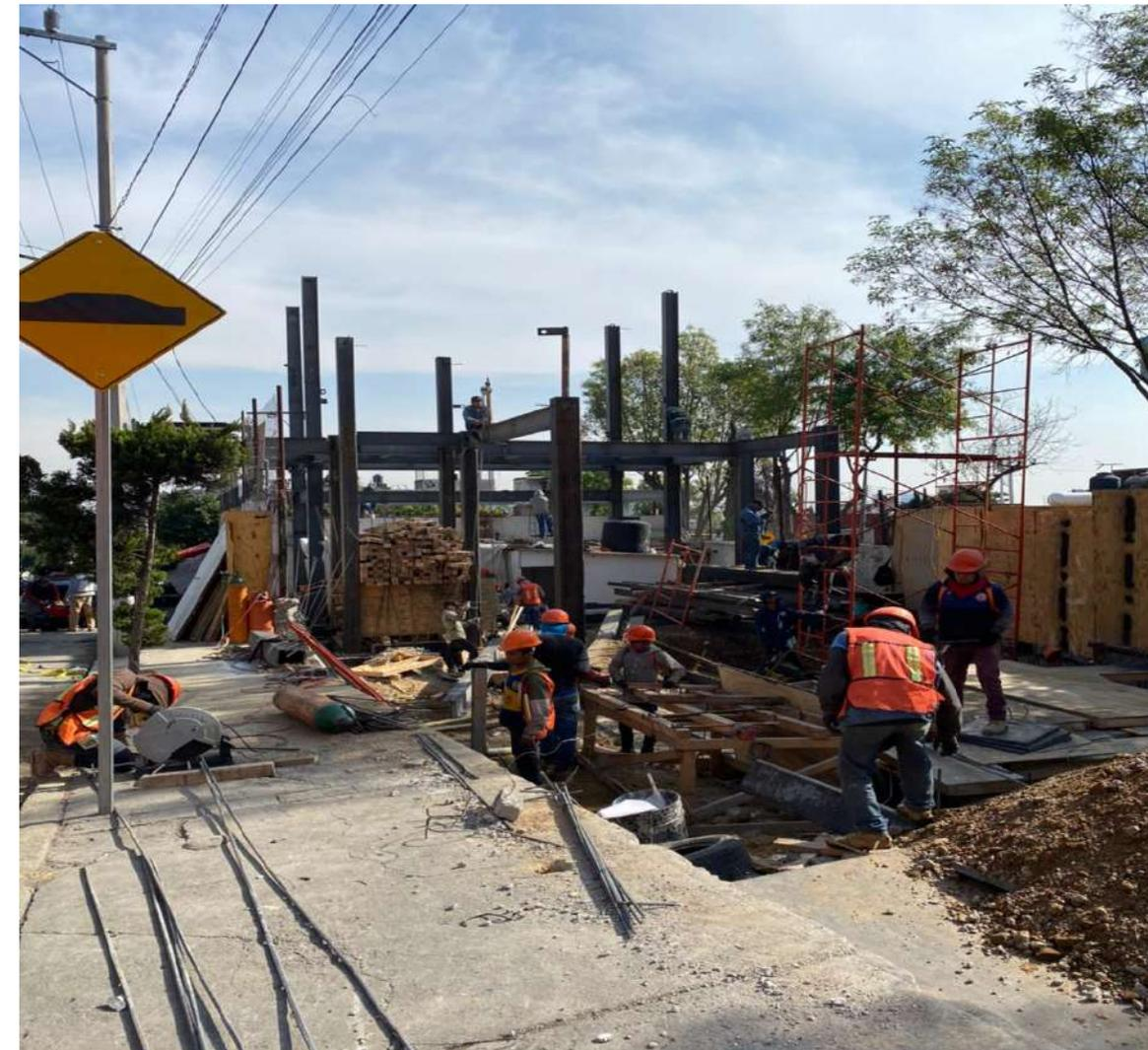
Excavación de cisterna y habilitado de acero A-36 para estructura
